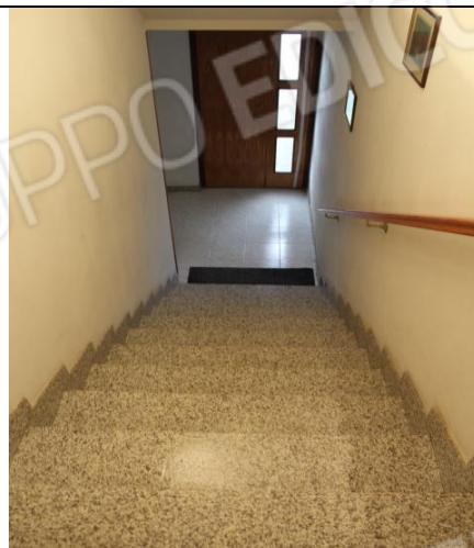
RAMPA SCALA VISTA DALL'ALTO
