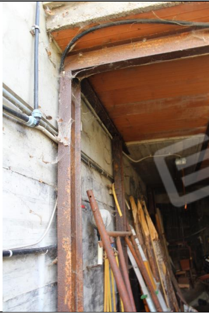
PARTICOLARE STRUTTURA PORTANTE IN FERRO
