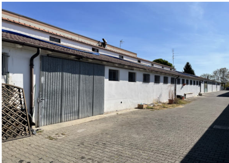
Vista esterna del fabbricato
