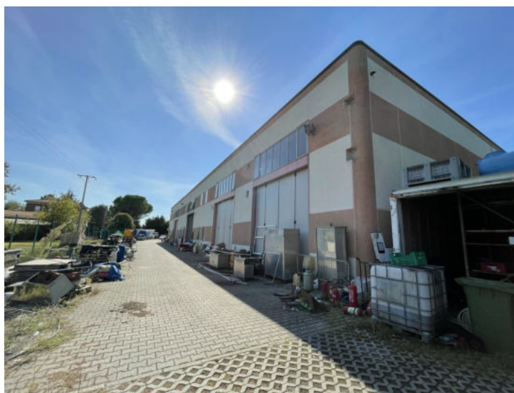
Vista esterna del fabbricato
