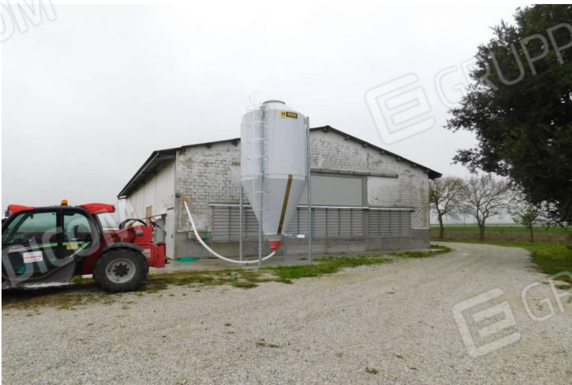
Foto 22 – Fabbricato uso Allevamento – prospetto.
