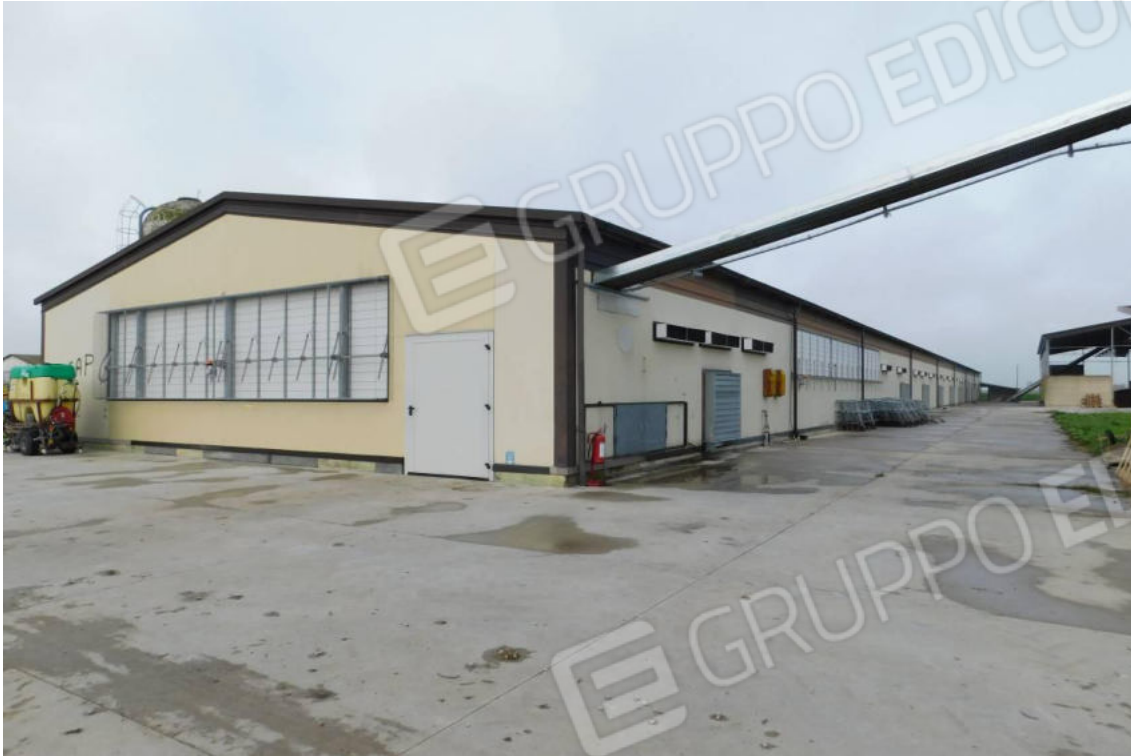
Foto 35 – Fabbricato uso Allevamento – prospetti sud-est.
