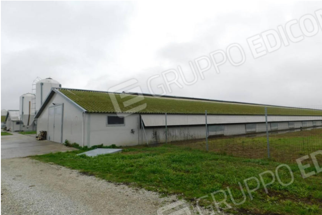
Foto 49 – Fabbricati uso Allevamento – prospetti nord-ovest.
