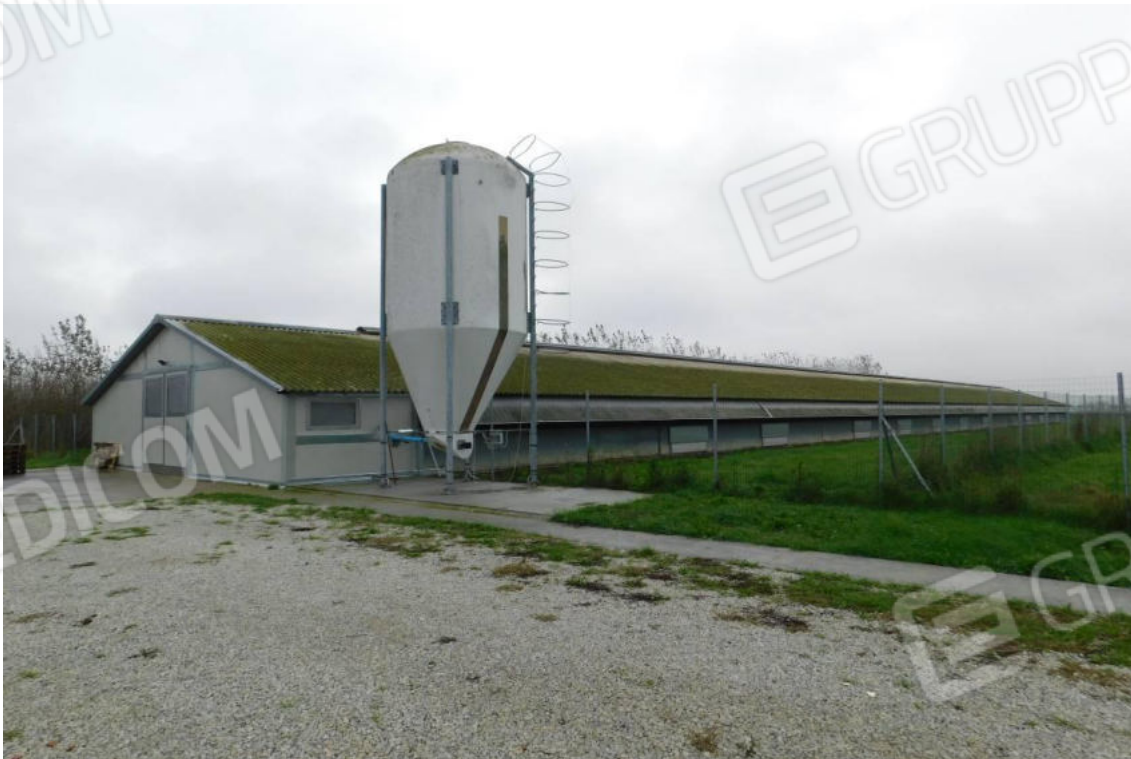
Foto 48 – Fabbricati uso Allevamento – prospetto nord-ovest.
