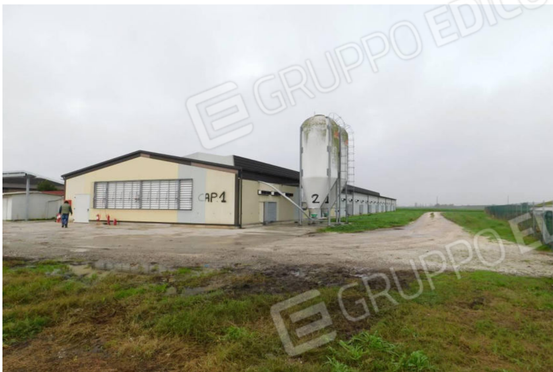
Foto 41 – Fabbricato uso Allevamento – prospetti sud-est.
