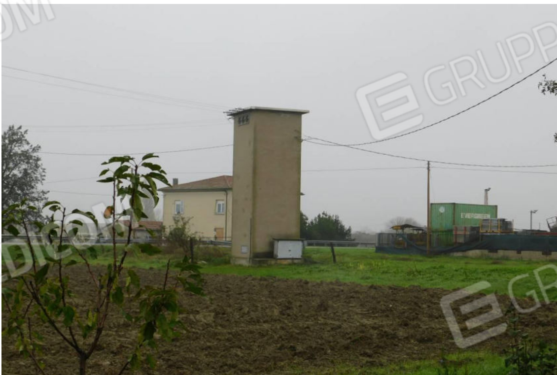
Foto 58 – Vista terreno (particolare cabina Enel Mapp. 17).
