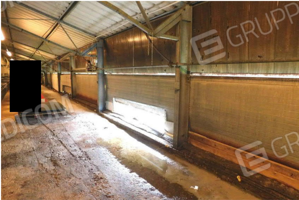
Foto 54 – Interno Fabbricati L-M-N-O.
