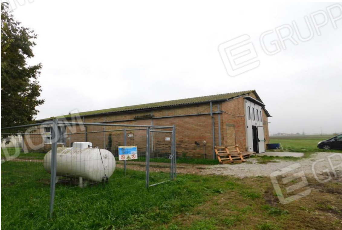
Foto 28 – Fabbricato uso Allevamento (confezionamento) – prospetto.
