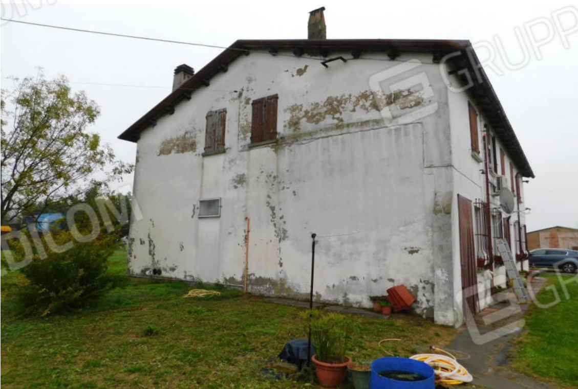
Foto 6 – Vista fabbricato abitativo prospetto est.
