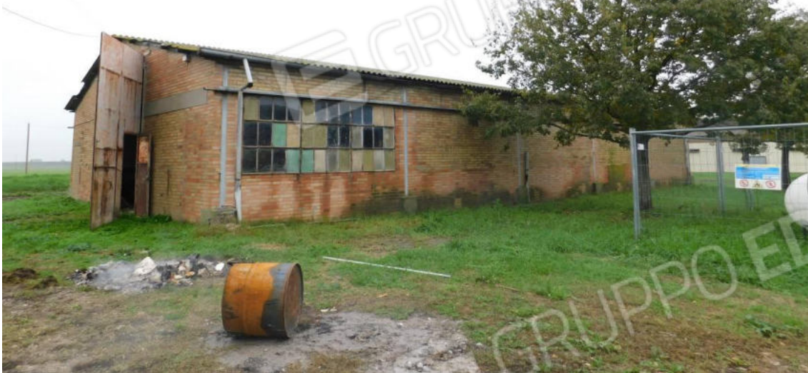
Foto 33 – Fabbricato uso Allevamento (deposito) – prospetto.
