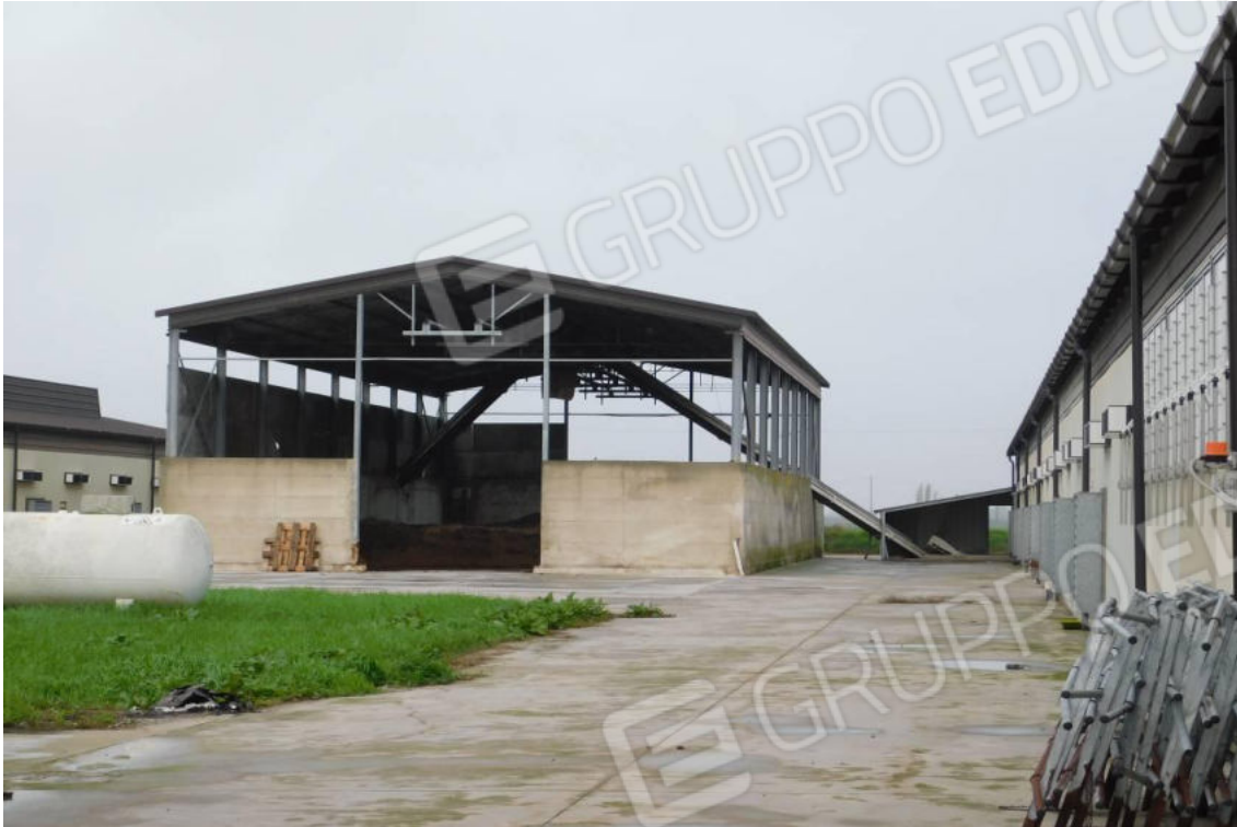
Foto 39 – Fabbricato uso concimaia – prospetti sud-est.
