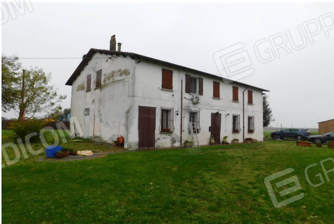
Foto 4 – Vista fabbricato abitativo prospetti sud-ovest.
