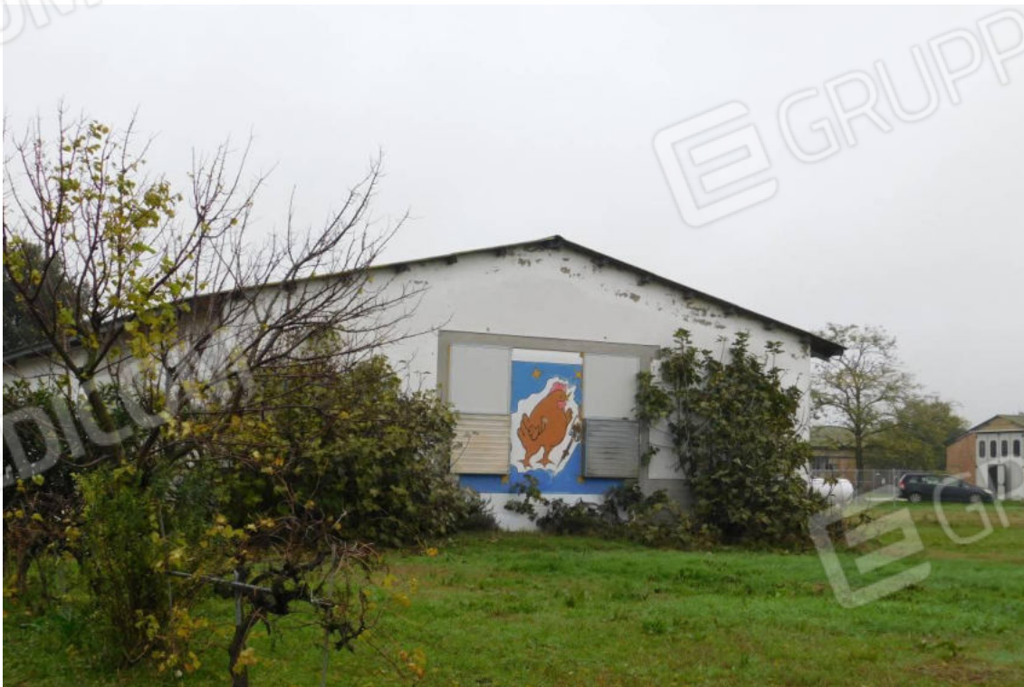
Foto 24 – Fabbricato uso Allevamento – prospetto.
