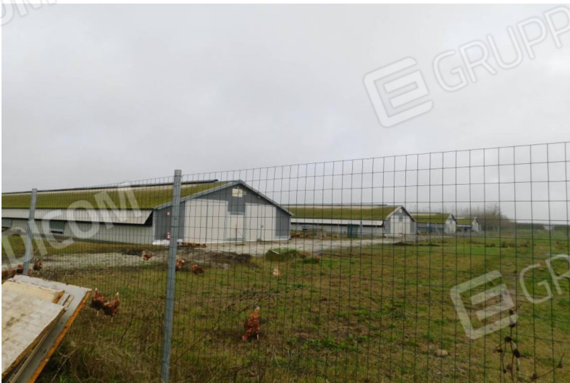
Foto 50 – Fabbricati uso Allevamento – prospetti sud-ovest.
