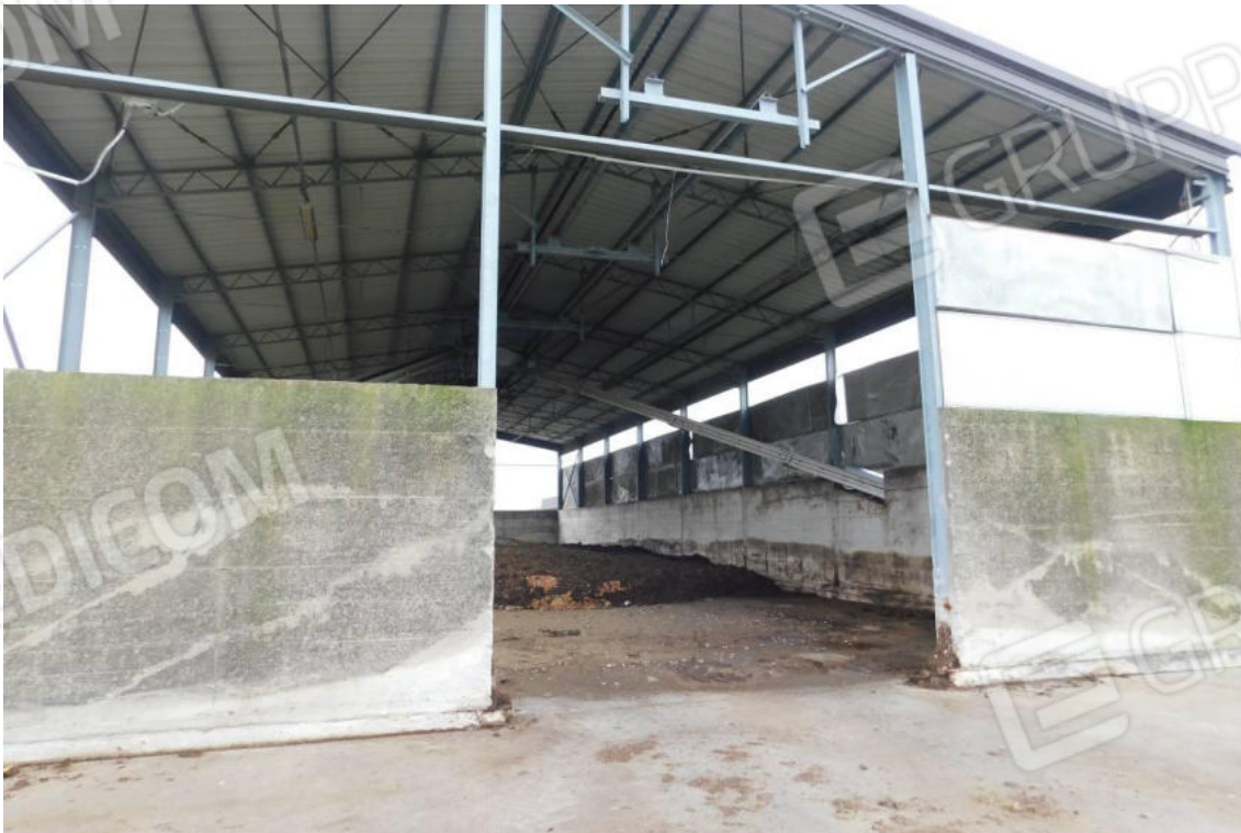
Foto 40 – Fabbricato uso concimaia – prospetto nord.
