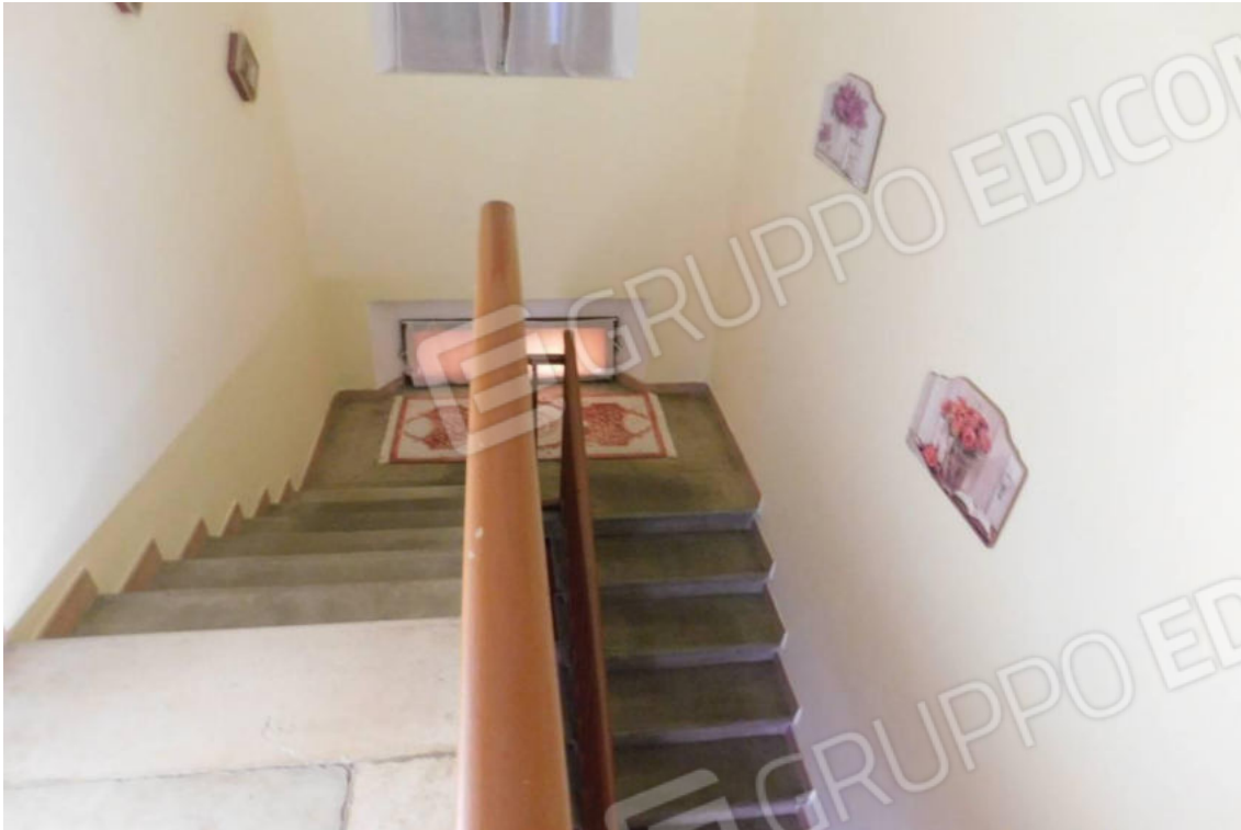
Foto 11 – Interno abitazione – Particolare vano scala PT-P1.
