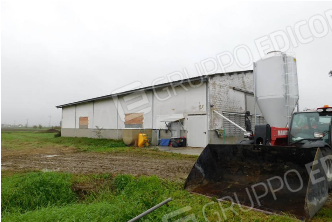
Foto 23 – Fabbricato uso Allevamento – prospetto.
