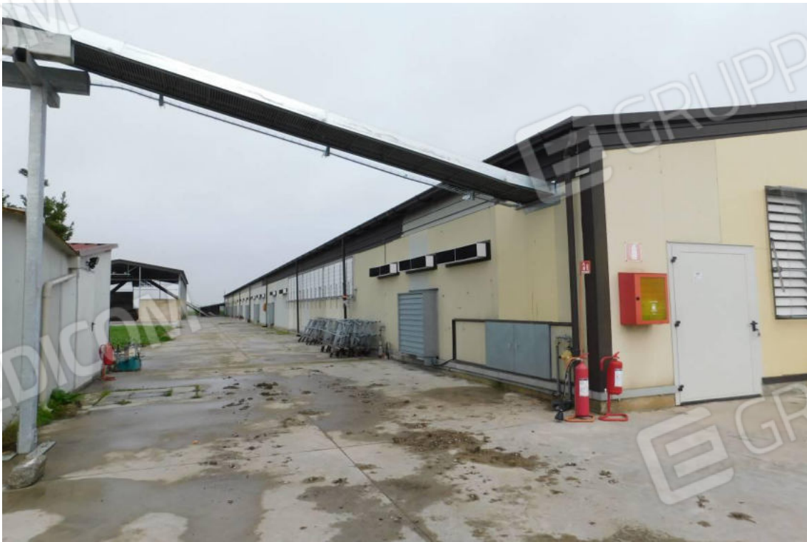
Foto 44 – Fabbricato uso Allevamento – prospetto ovest.
