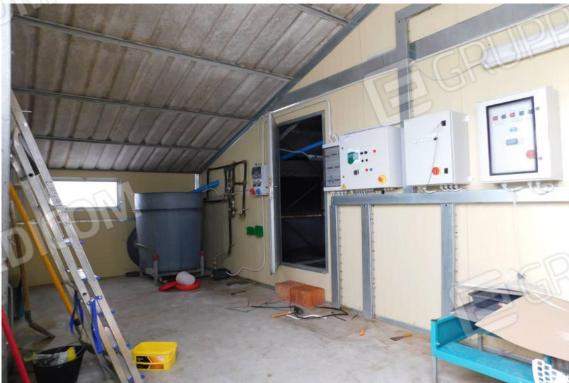
Foto 52 – Interno Fabbricati L-M-N-O – Ingresso.
