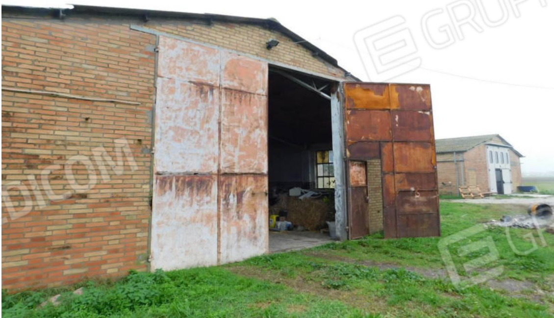
Foto 32 – Fabbricato uso Allevamento (deposito) – prospetto.
