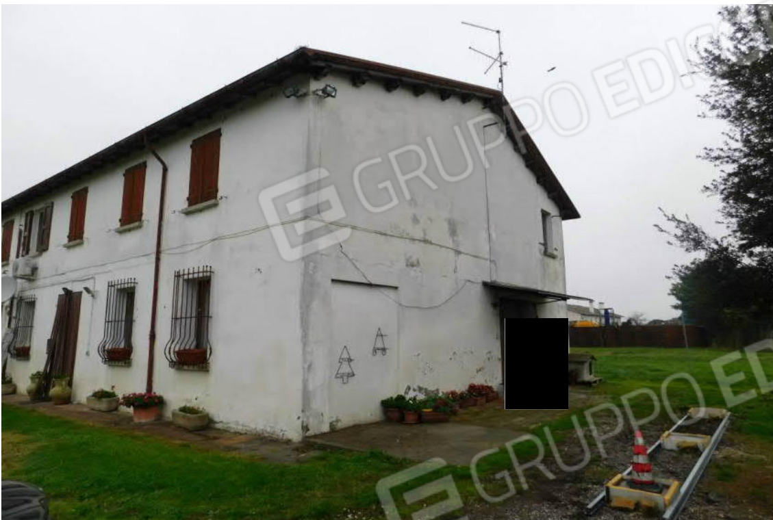
Foto 5 – Vista fabbricato abitativo prospetti sud-est.
