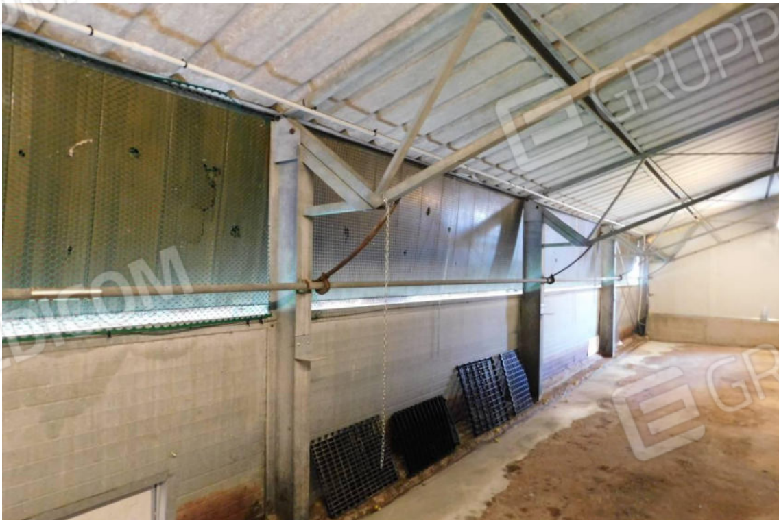
Foto 56 – Interno Fabbricati L-M-N-O.
