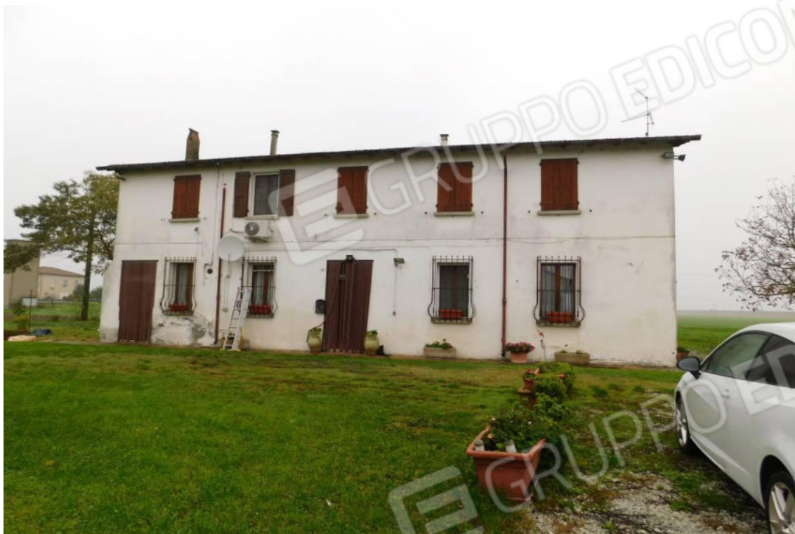
Foto 3 – Vista fabbricato abitativo prospetto principale.
