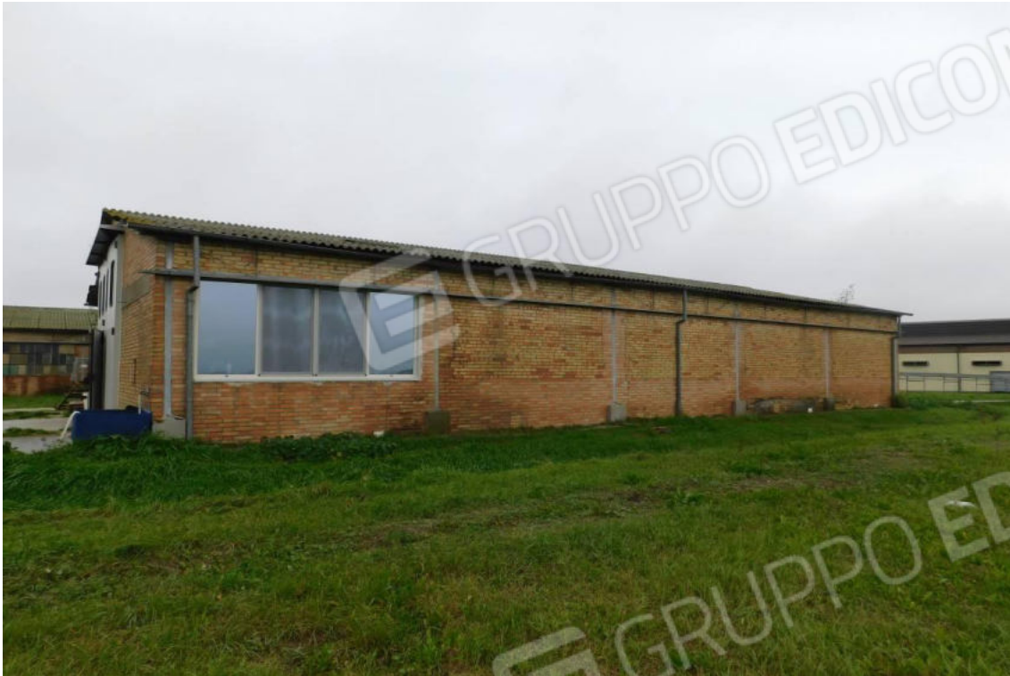
Foto 27 – Fabbricato uso Allevamento (confezionamento) – prospetto.
