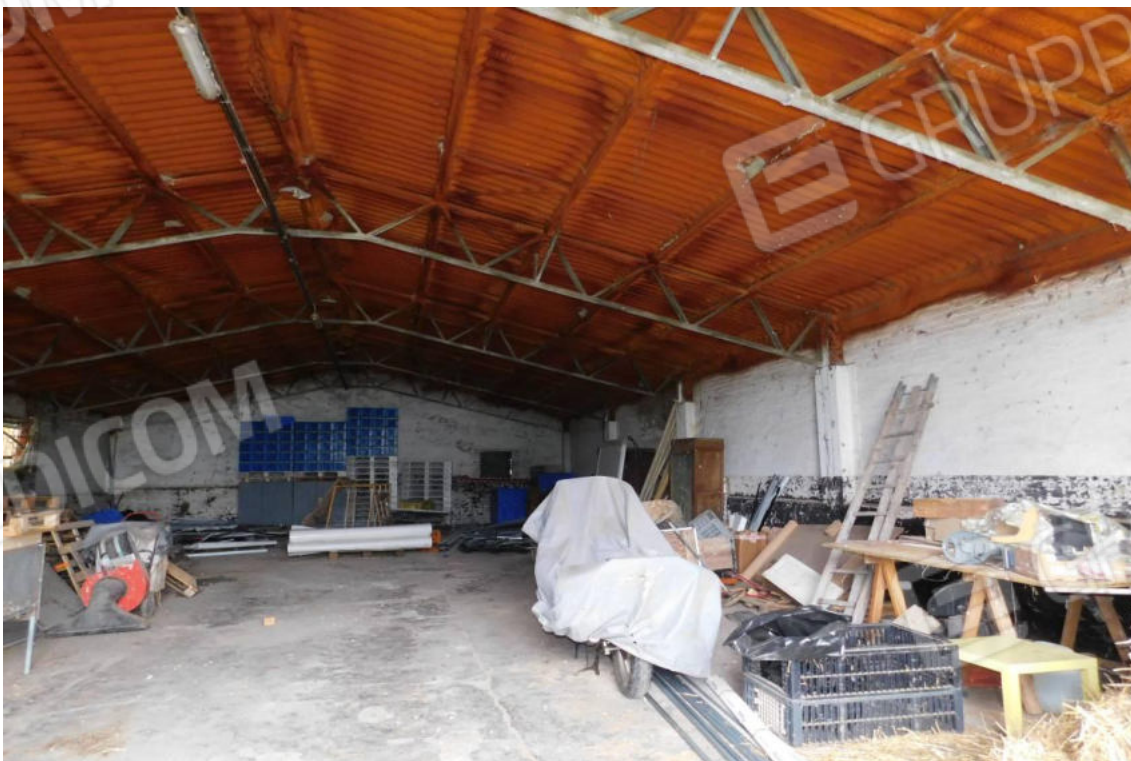
Foto 34 – Interno Fabbricato E.
