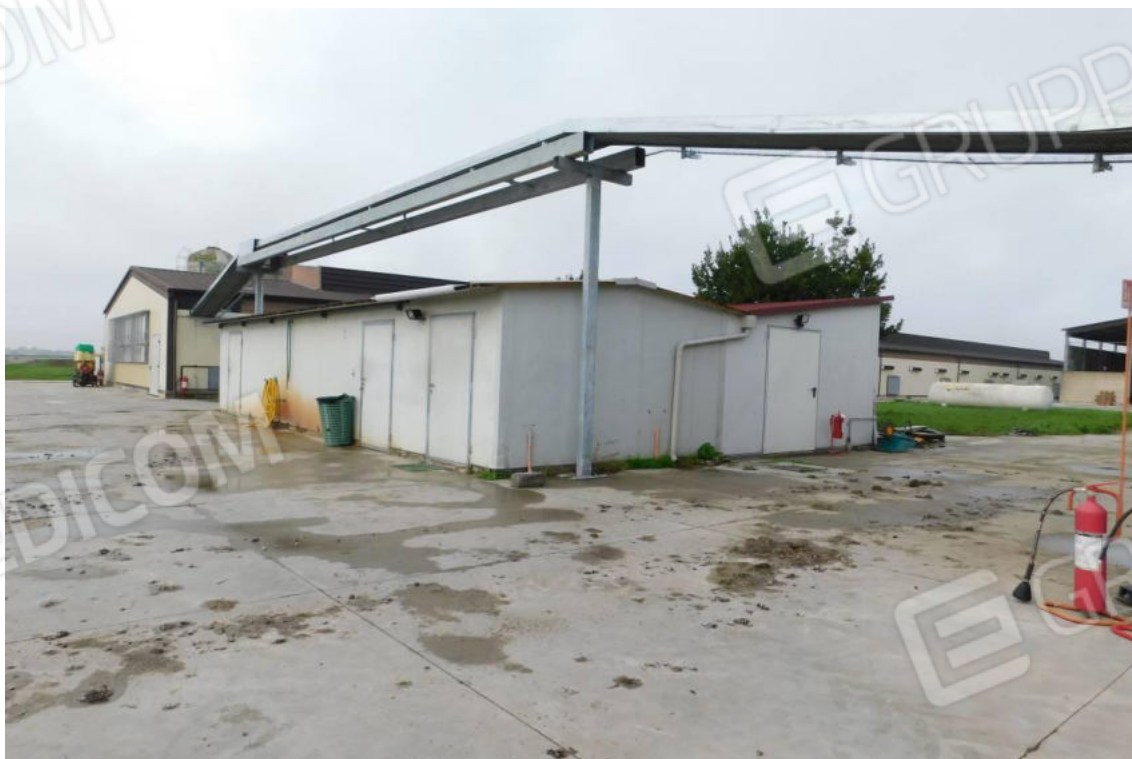
Foto 46 – Fabbricato uso locale tecnico – prospetti sud-est.
