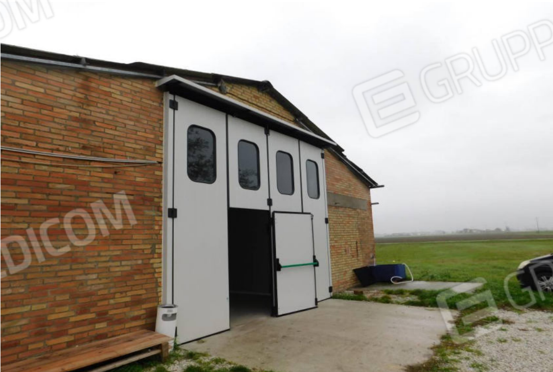
Foto 26 – Fabbricato uso Allevamento (confezionamento) – prospetto.
