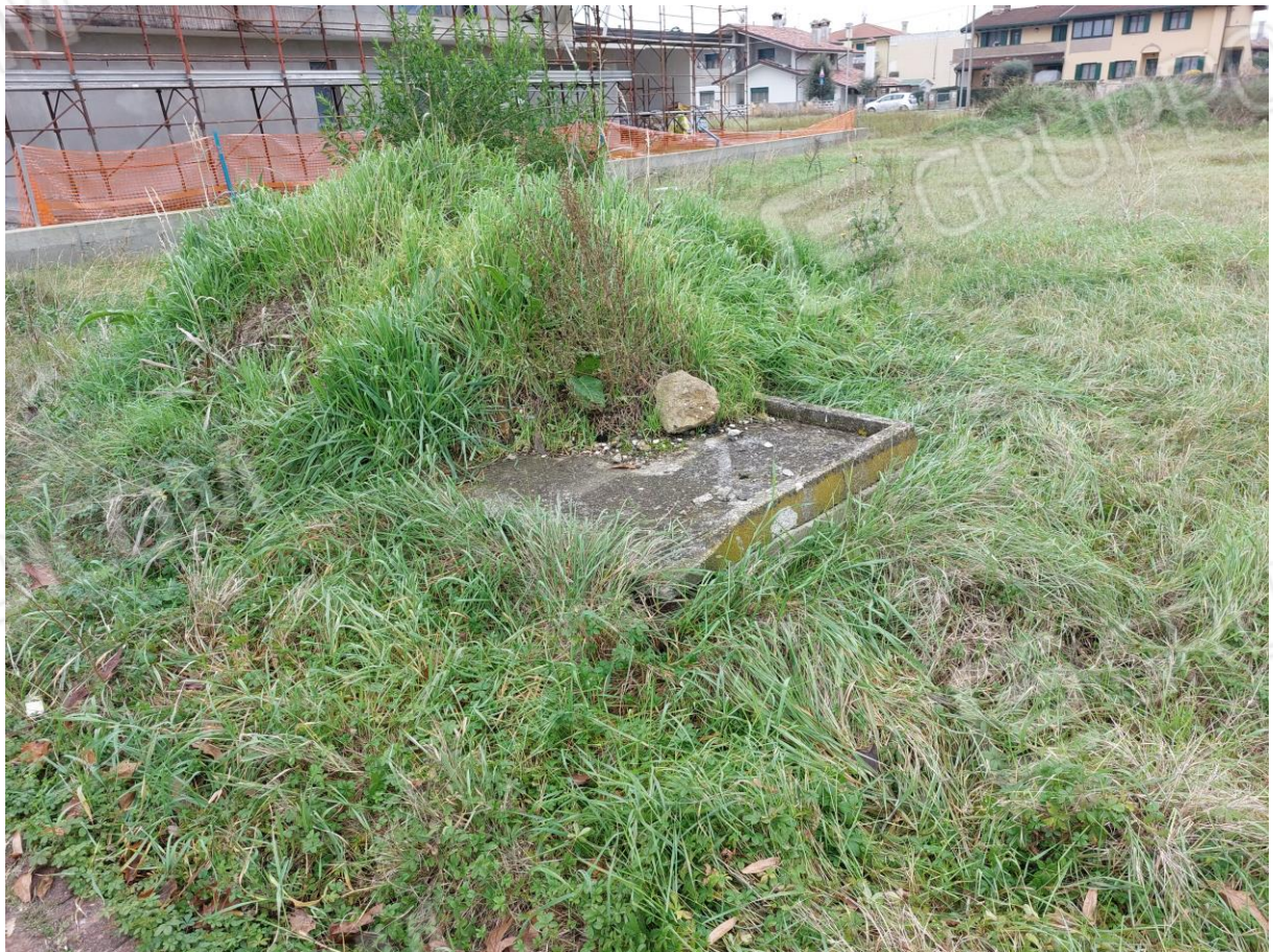
Foto n° 2 - Lotto 7 - Comune di San Michele al Tagliamento (VE) - Frazione Cesarolo - Foglio 38 m.le 952 - Particolare del manufatto presente nel terreno, in prossimità di Via Gioacchino Colle.
