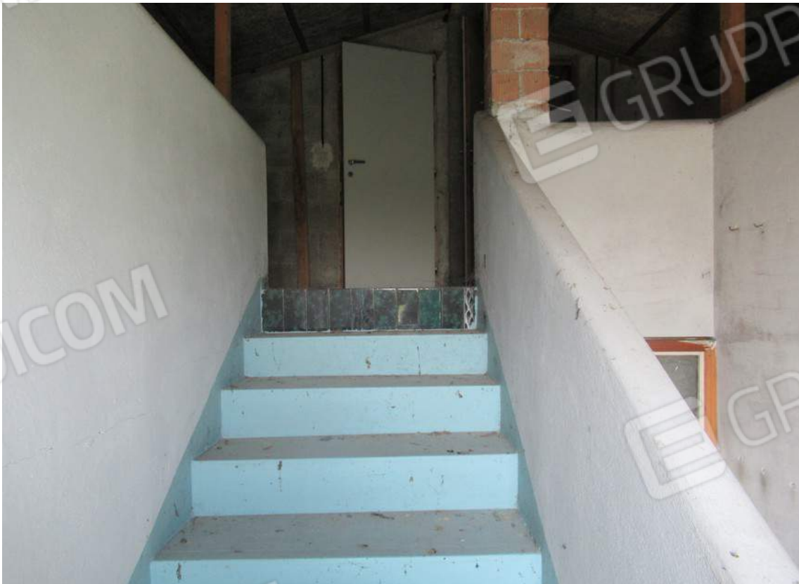
Foto 12: Scala collegamento alla soffitta
