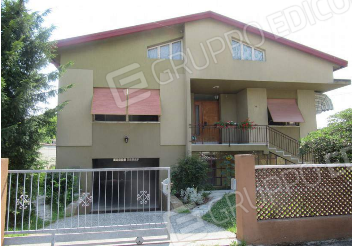
Foto 1: Vista abitazione dalla Via Reghena
