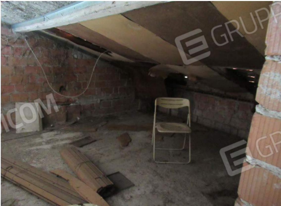
Foto 14: Soffitta angolo Sud-Ovest
