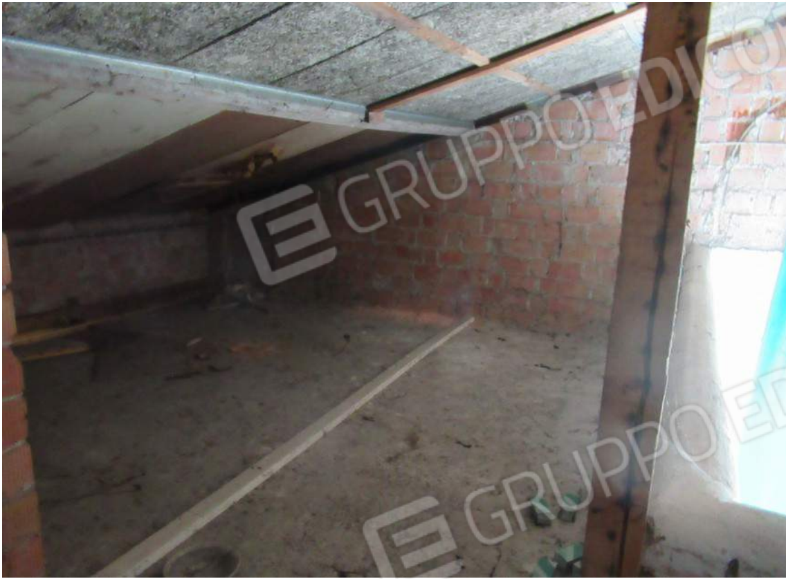
Foto 13: Soffitta angolo Nord-Est
