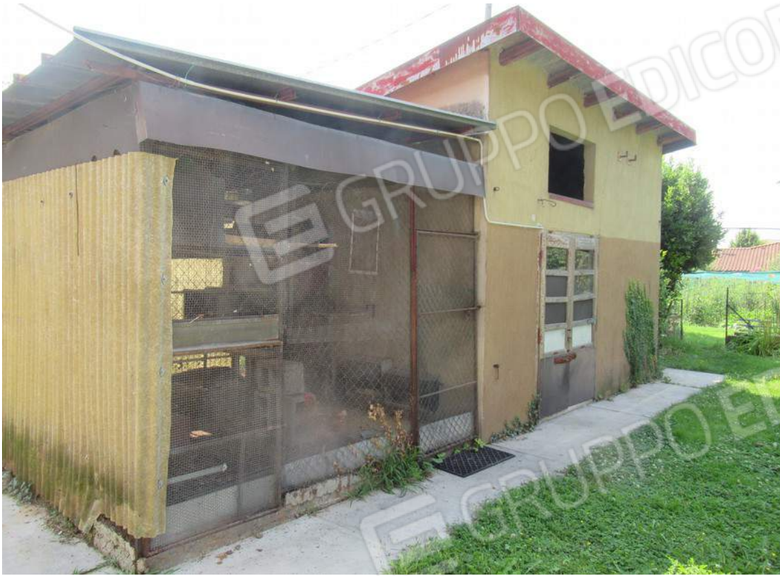
Foto 15: Vista tettoia e ripostiglio
