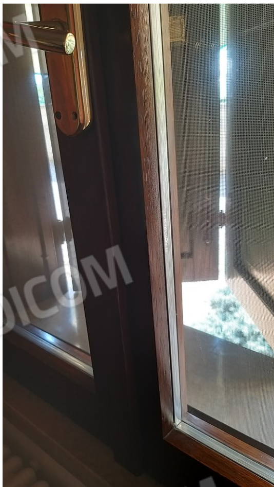
Foto n° 23 - Lotto 1 - Comune di Azzano Decimo (PN) - Foglio 19, m.le 496 sub 3 - Piano terra. Particolare dei serramenti in legno e vetrocamera presenti in soggiorno e taverna.
