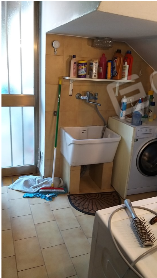
Foto n° 36 - Lotto 1 - Comune di Azzano Decimo (PN) - Foglio 19, m.le 496 sub 3 - Piano terra. Veduta di parte della lavanderia in prossimità della porta secondaria di accesso alla zona esterna, in posizione sud-est.
