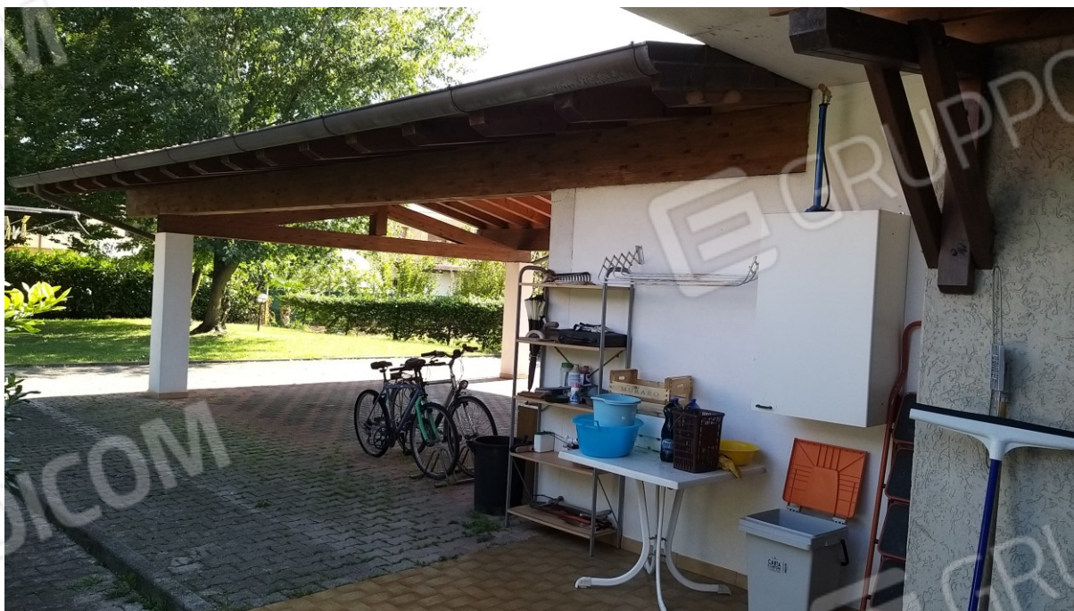
Foto n° 14 - Lotto 1 - Comune di Azzano Decimo (PN) - Foglio 19, m.le 496 sub 3. Particolare dell'ultimo tratto del piano terra e della tettoia; sullo sfondo il giardino.
