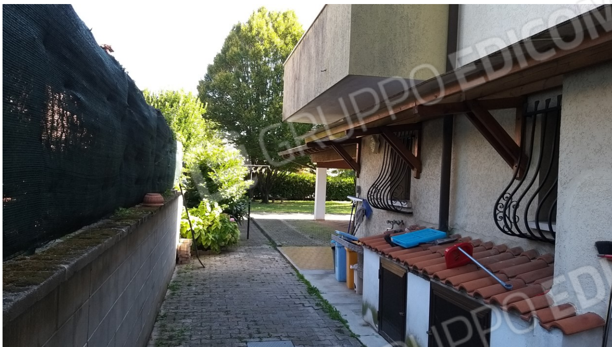
Foto n° 13 - Lotto 1 - Comune di Azzano Decimo (PN) - Foglio 19, m.le 496 sub 3. Veduta, da posizione nord-est, del piano terra in corrispondenza dei vani adibiti a centrale termica e lavanderia.
