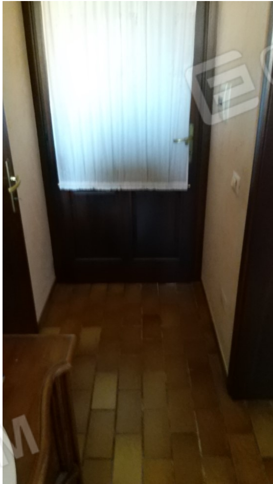
Foto n° 43 - Lotto 1 - Comune di Azzano Decimo (PN) - Foglio 19, m.le 496 sub 3 - Primo piano. Veduta, dall'interno dell'atrio, della porta di accesso alla terrazza esterna. A sinistra si nota parte della porta di accesso al vano ad uso WC.
