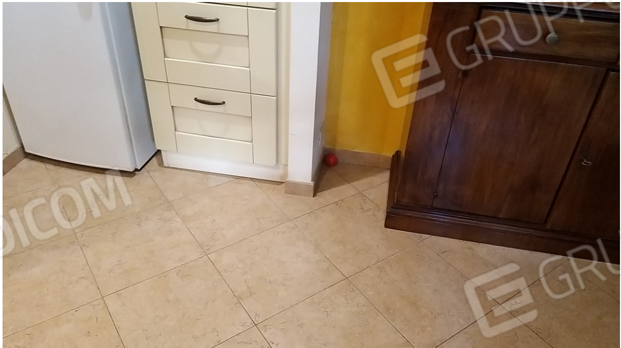
Foto n° 28 – Lotto 1 - Comune di Azzano Decimo (PN) – Foglio 19, m.le 496 sub 3 – Piano terra. Particolare della pavimentazione presente nel vano cucina.
