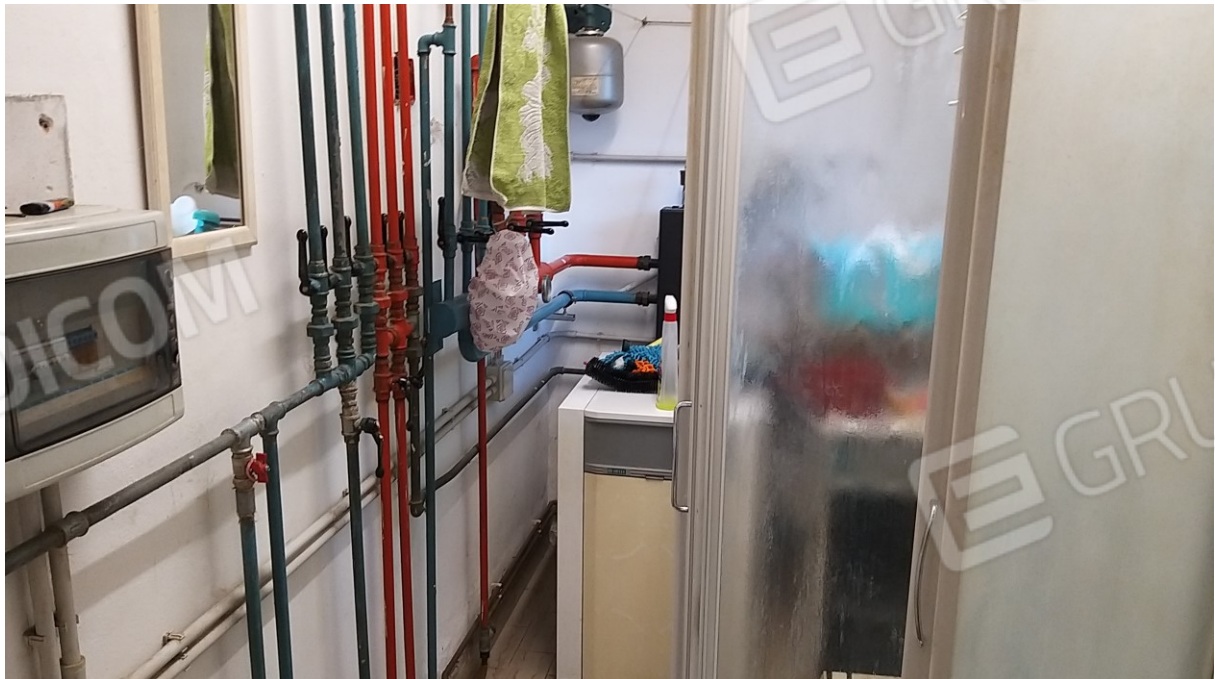
Foto n° 38 - Lotto 1 - Comune di Azzano Decimo (PN) - Foglio 19, m.le 496 sub 3 - Piano terra. Veduta, da posizione sud, del vano uso WC e centrale termica; come visibile nella foto, è presente anche un box doccia.
