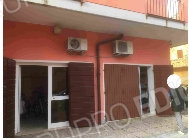
Veduta esterna - Sub. 45
