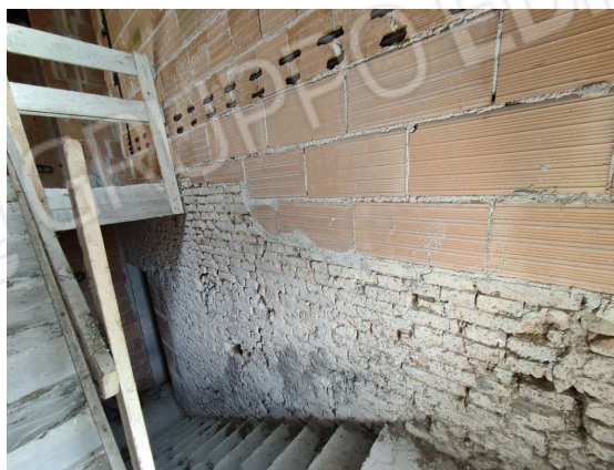
vano scala piano sottotetto
