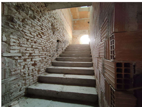
vano scala piano sottotetto
