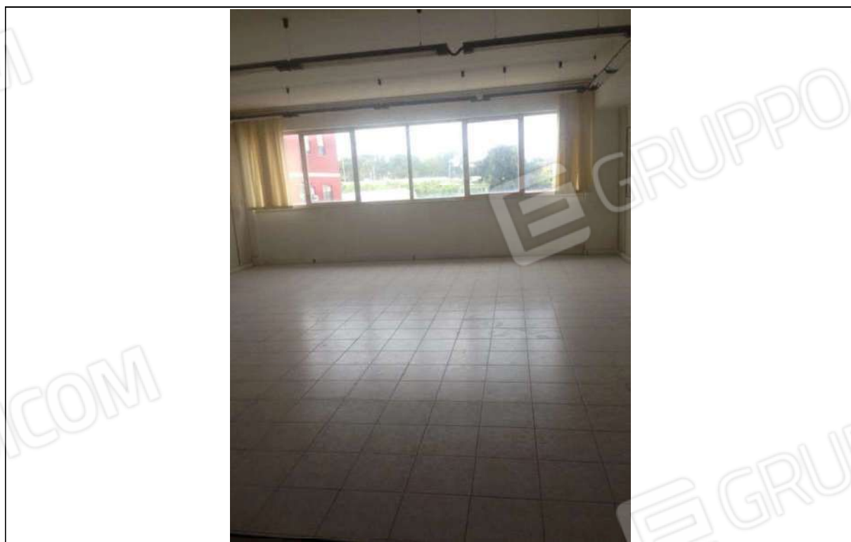
FOTO 20 : Veduta interna piano primo ufficio
