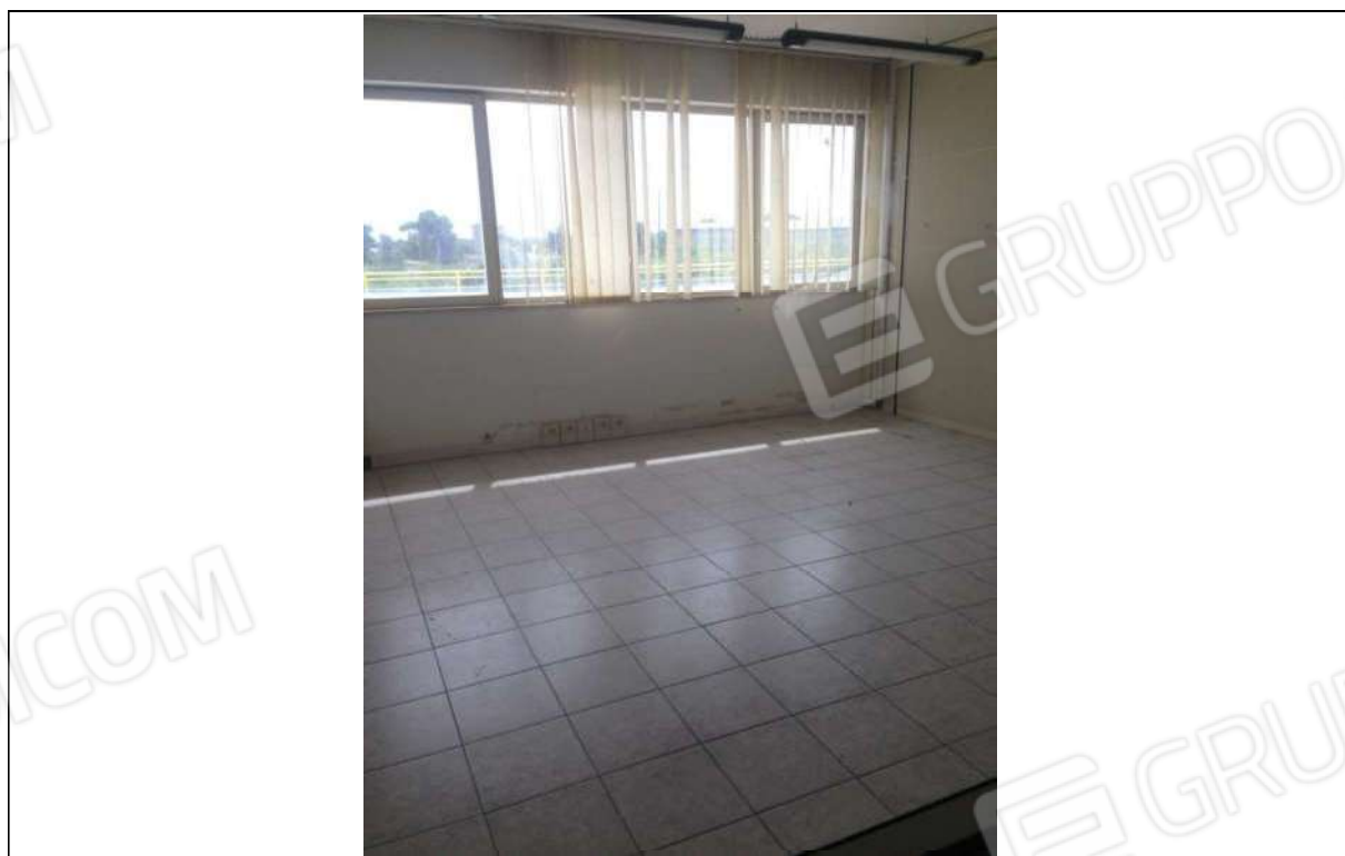
FOTO 24 : Veduta interna piano primo ufficio
