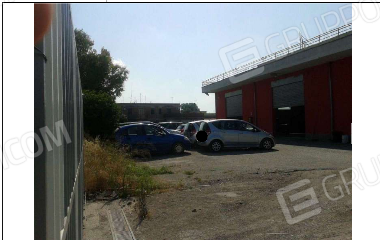
FOTO 2 : Veduta esterna capannone
