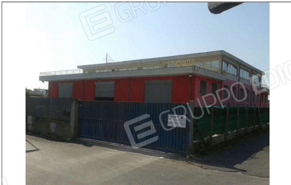
FOTO 1 : Veduta esterna capannone.
