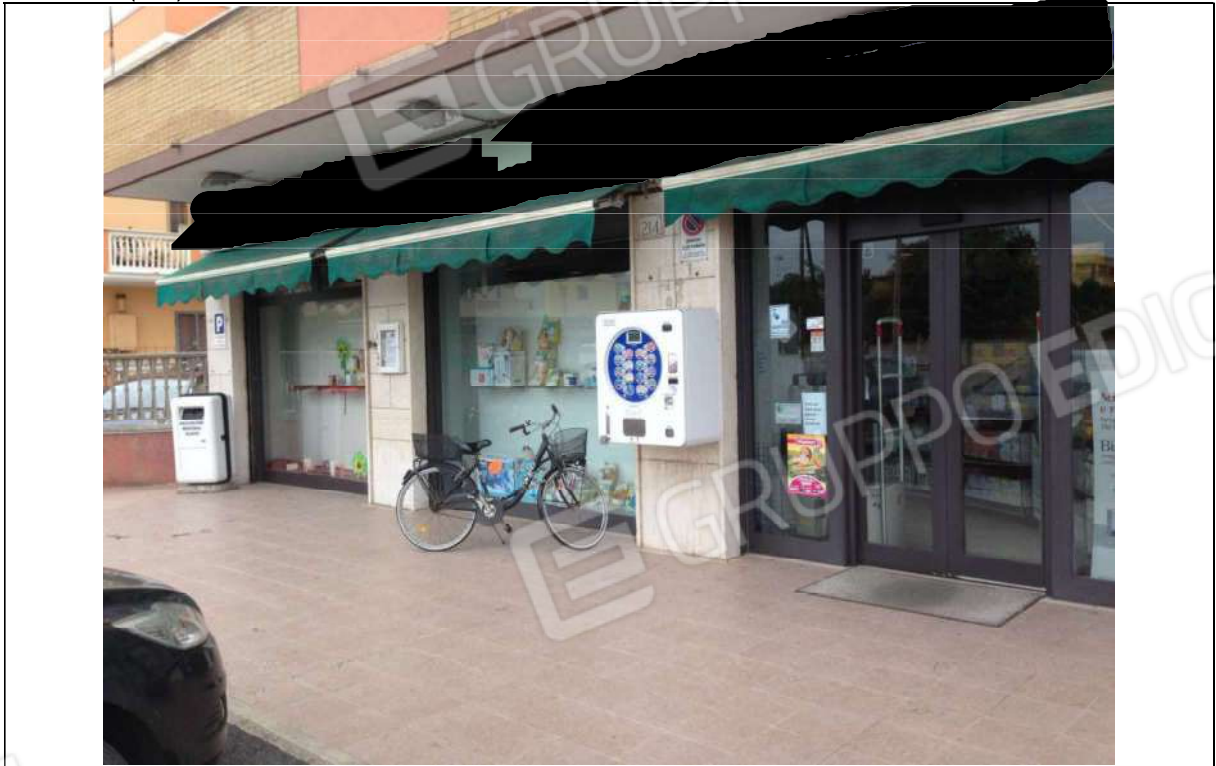
FOTO 1 : VEDUTA ESTERNA immobile via Giorgio Giorgis, 214/b/c/d
