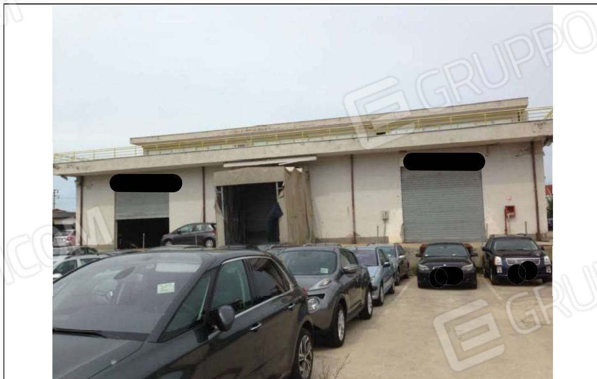
FOTO 6 : Veduta esterna capannone
