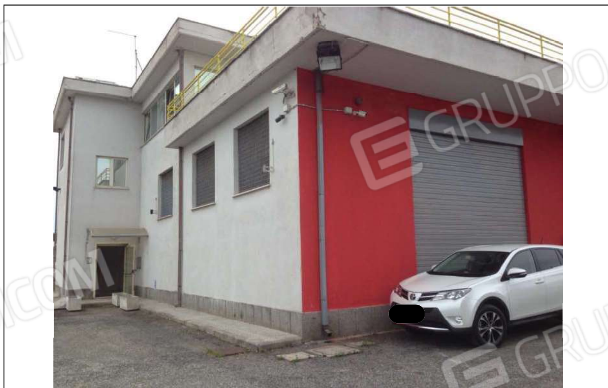
FOTO 8 : Veduta esterna capannone
