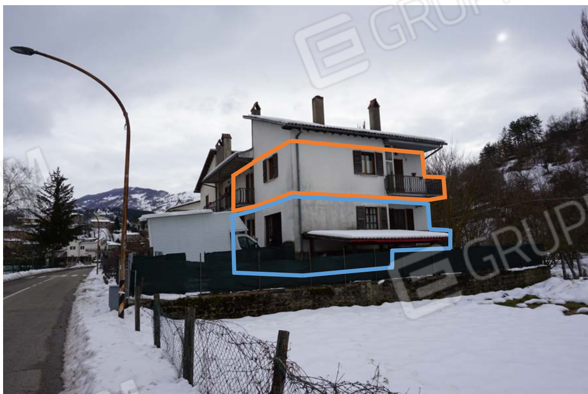
Foto n. 4 Esterno del Fabbricato Prospetto Nord - Est Lotto 001 - 002 - 003 - 004
