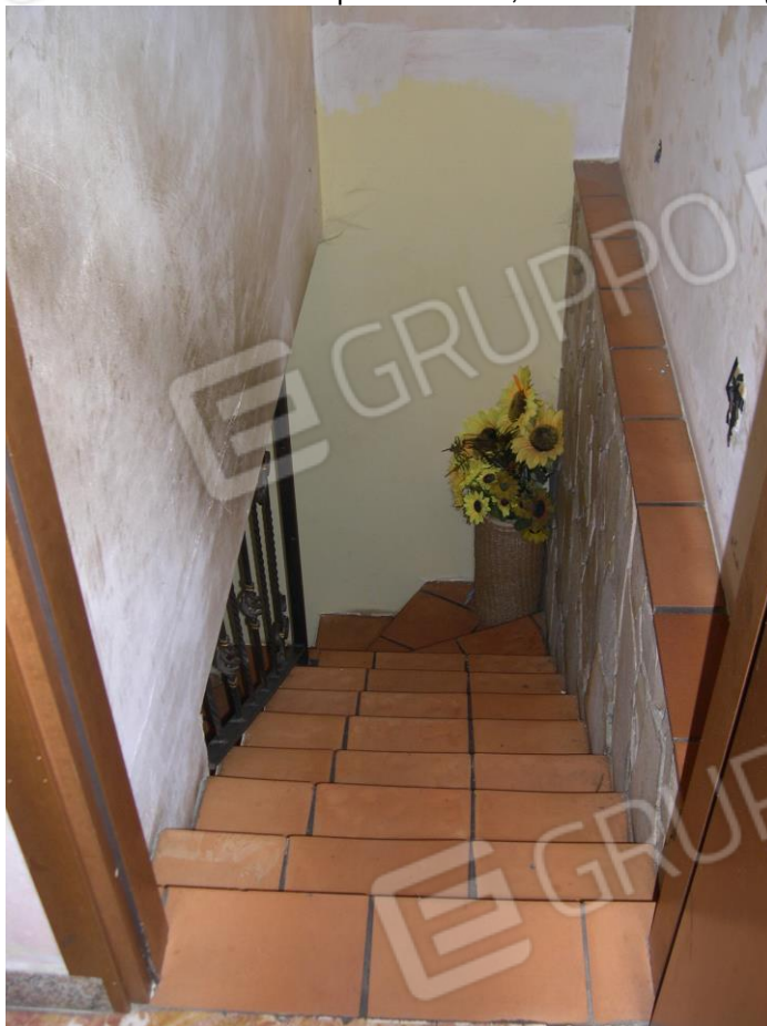
FOTO N°24: Vista interna dell'abitazione al piano rialzato, vano scala di collegamento col P.S.1.
