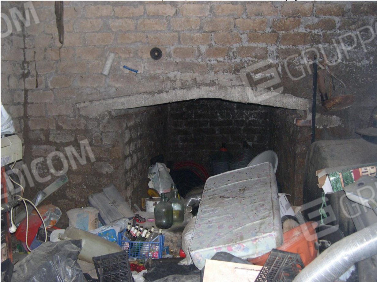
FOTO N°17: Vista interna del cespite al piano seminterrato, cantina (e grotta) 2/2.
