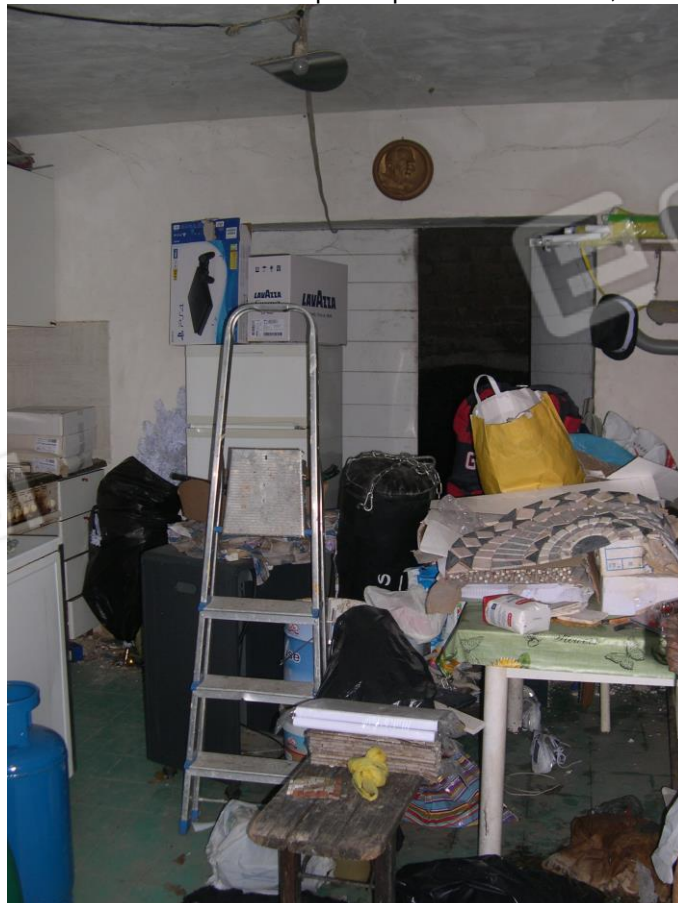
FOTO N°15: Vista interna del cespite al piano seminterrato, cantina 1/2.
