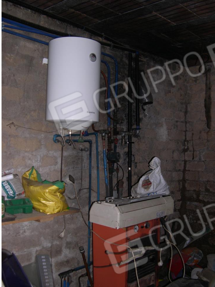
FOTO N°16: Vista interna del cespite al piano seminterrato, cantina 2/1.
