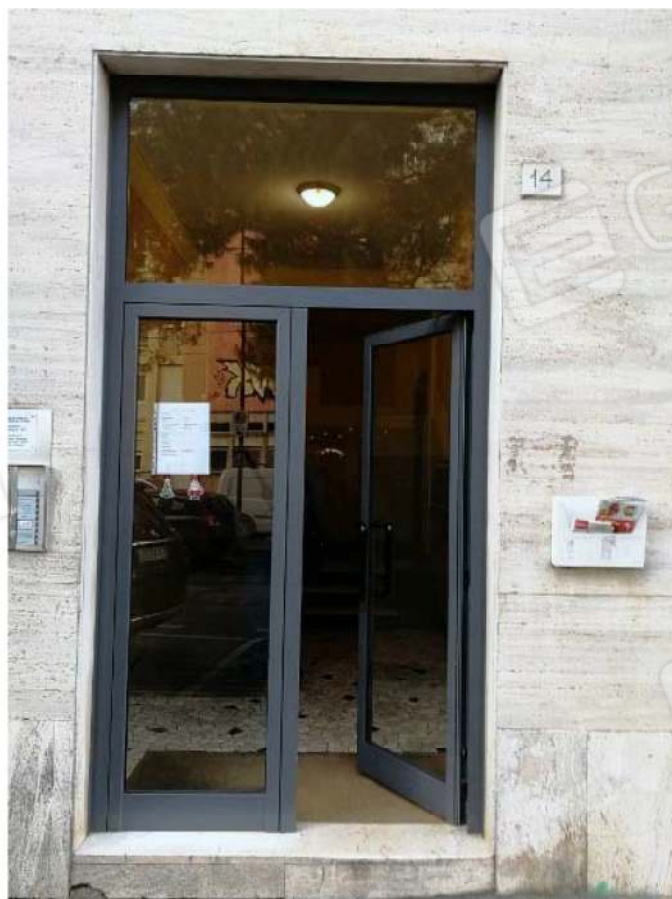
Foto 04 – esterno edificio, ingresso condominiale
