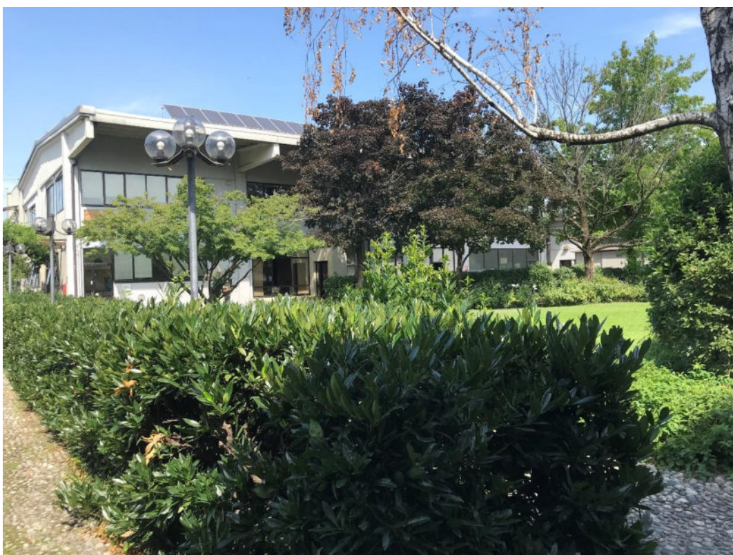
Foto 4. Mapp. 207 sub. 24: corte a sud del capannone subb. 26, 27 verso via Trepola
