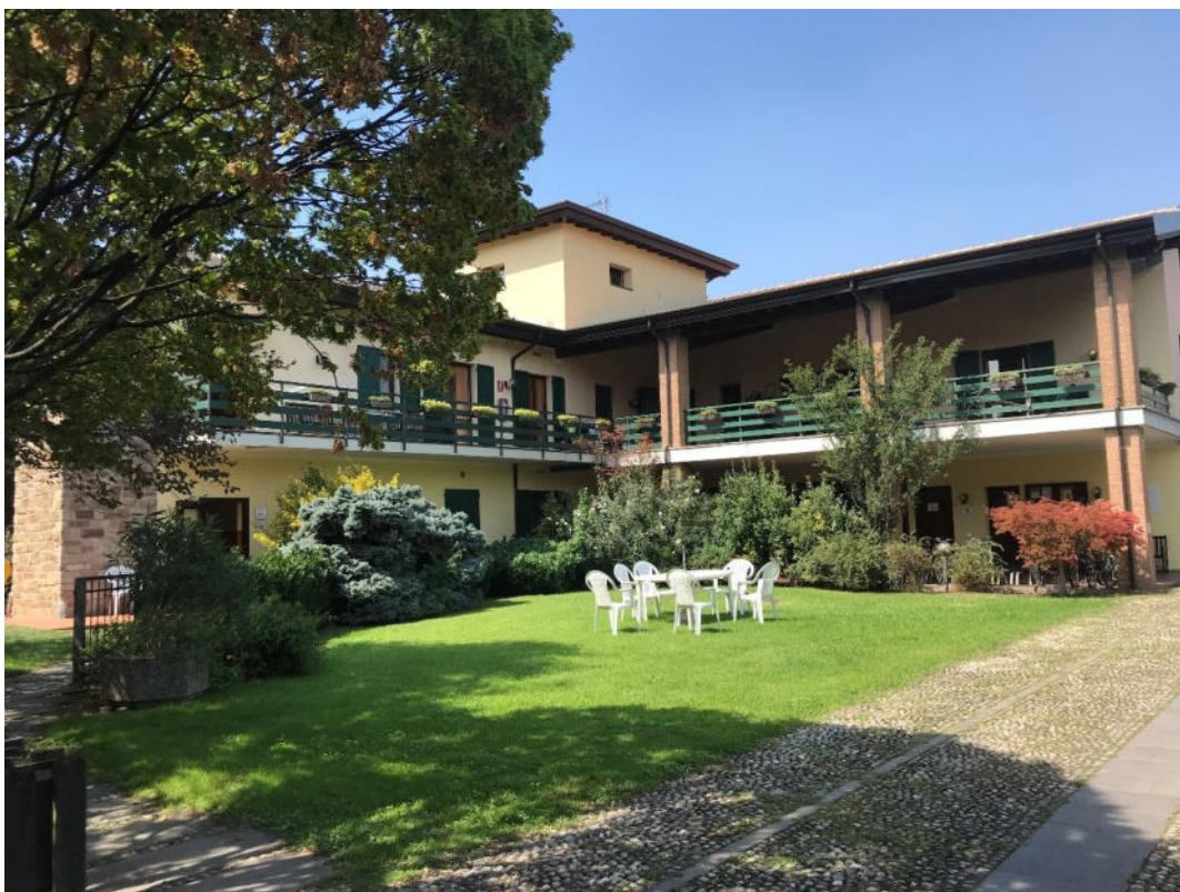
Foto 3. Mapp. 207 sub. 24: corte a sud delle residenze al sub. 16, verso via Trepola
