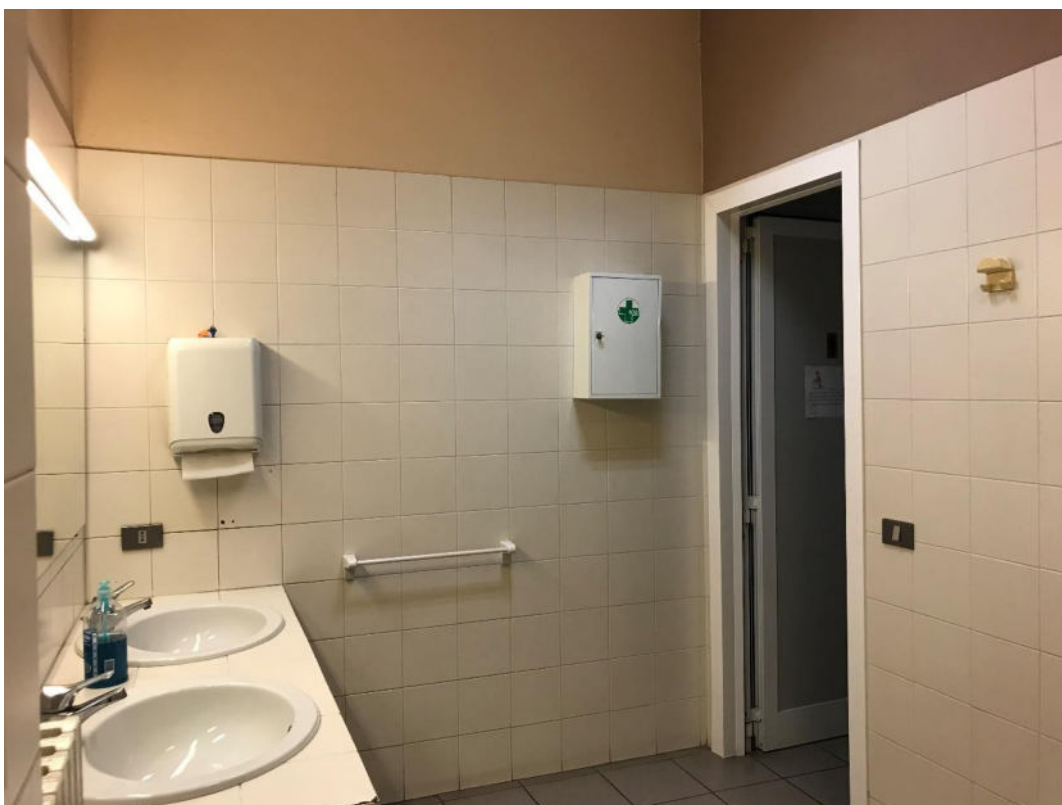
Foto 9. Mapp. 207 sub. 26: servizi igienici presso gli uffici
