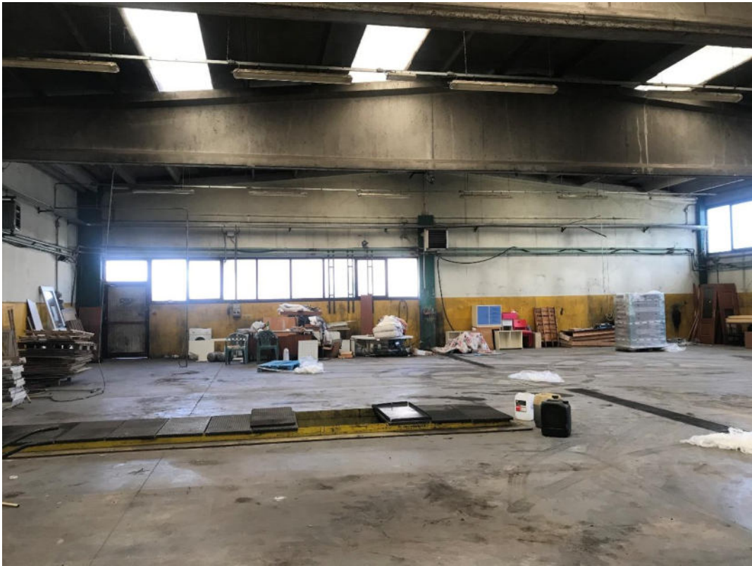
Foto 3. Mapp. 207 sub. 26: Officina verso lato nord con ingresso pedonale
