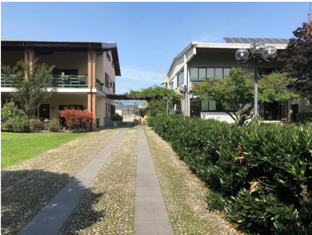
Foto 2. Accesso da via Trepola, a ovest, all'area urbana mapp. 207 sub. 24
