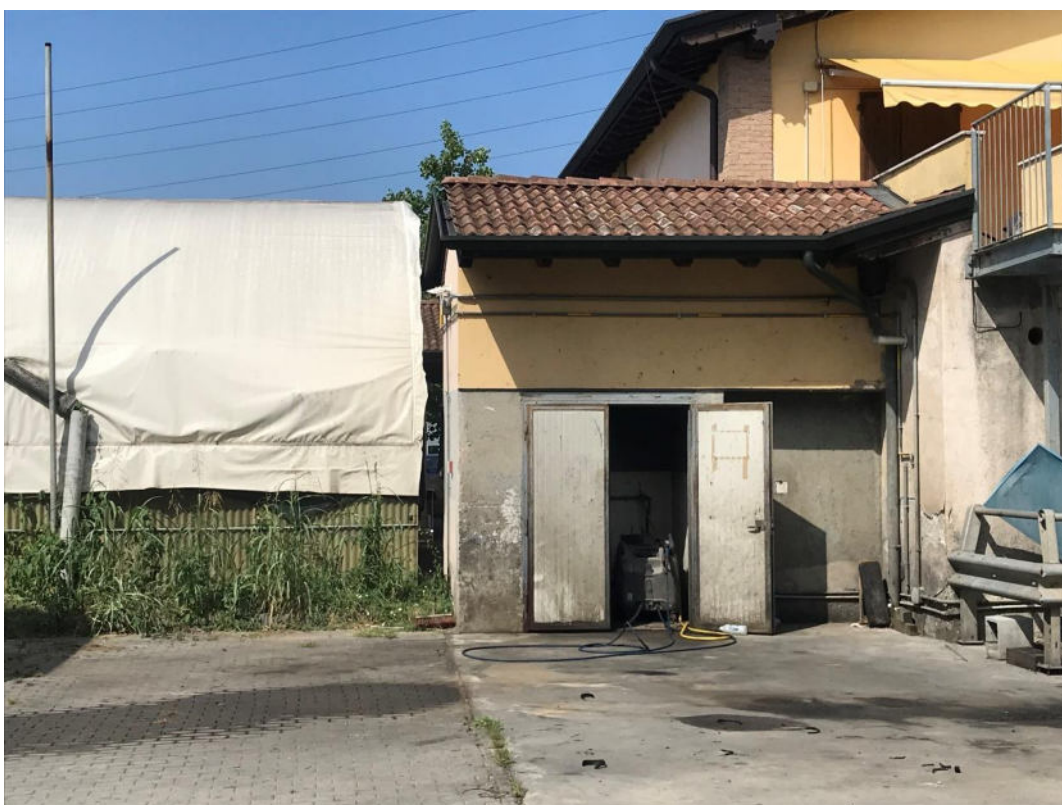
Foto 14. Mapp. 207 sub. 26: locale tecnico sito nel corpo esterno a nord del capannone
