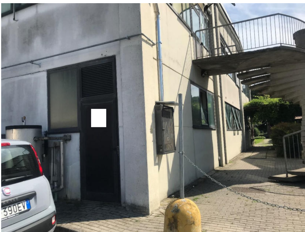
Foto 2. Mapp. 207 sub. 26, PT: centrale termica e prospetto ovest (lato spogliatoi)
