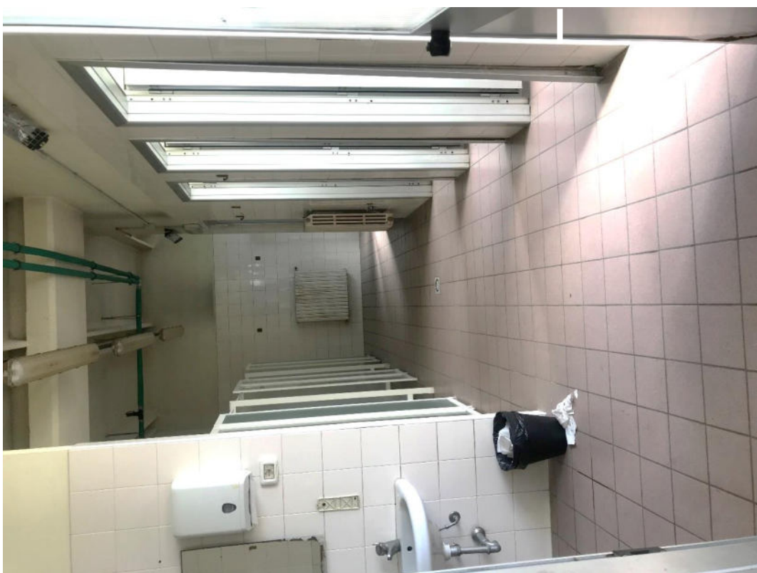
Foto 16. Mapp. 207 sub. 26: servizi igienici e docce collegati allo spogliatoio
