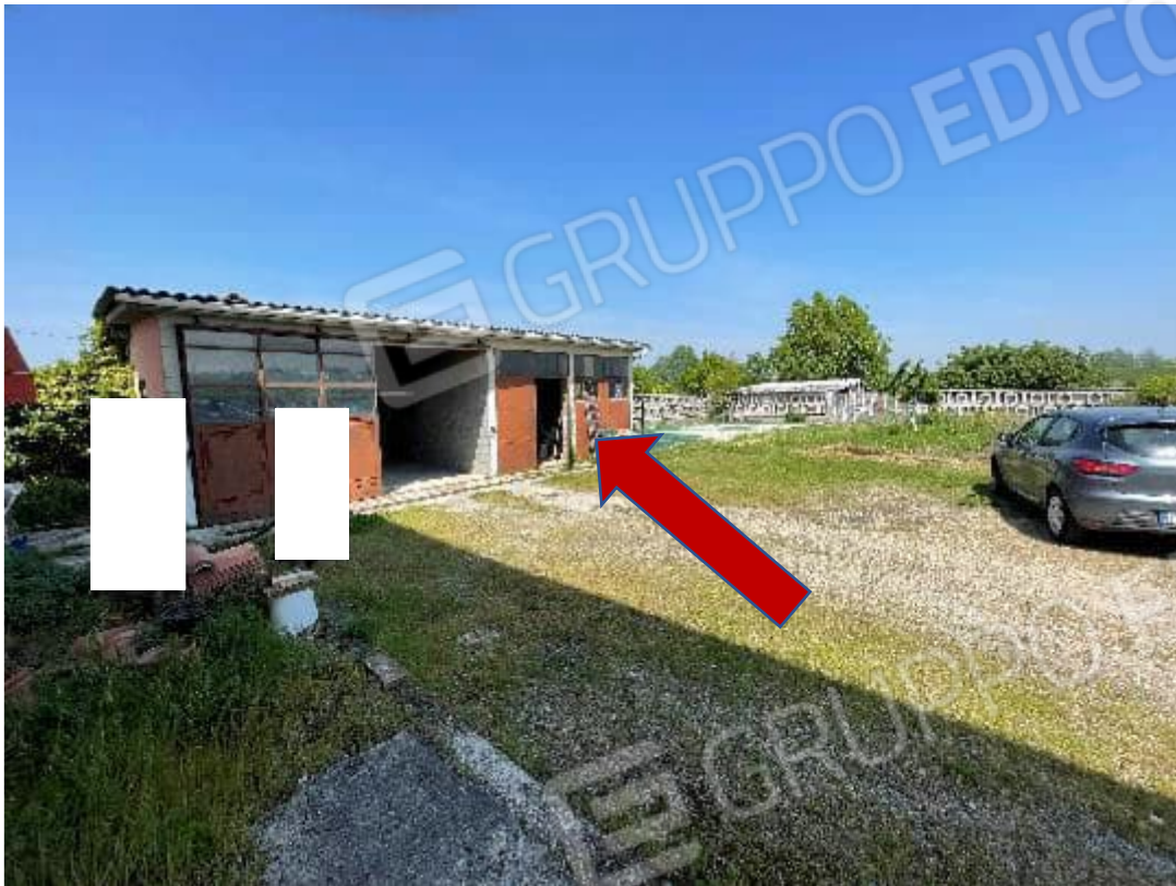
Vista esterno corpo di fabbrica : freccia rossa indica l'autorimessa n.1
