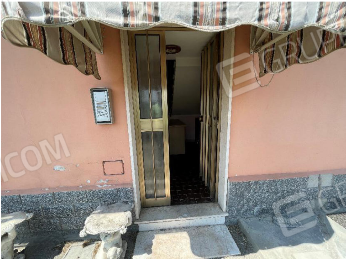
Entrata Vano Scale Comune
