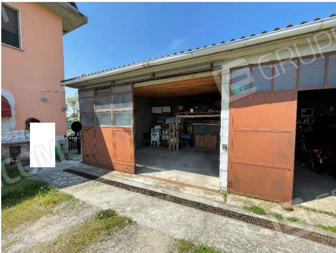
Vista Interna Ingresso
