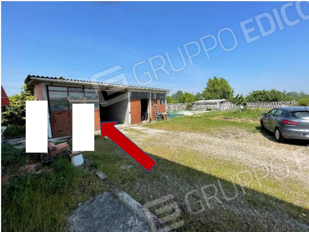
Vista esterno corpo di fabbrica : freccia rossa indica l'autorimessa n.2
