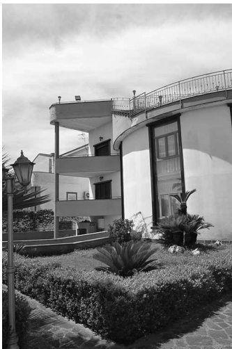
_facciata principale della villa
