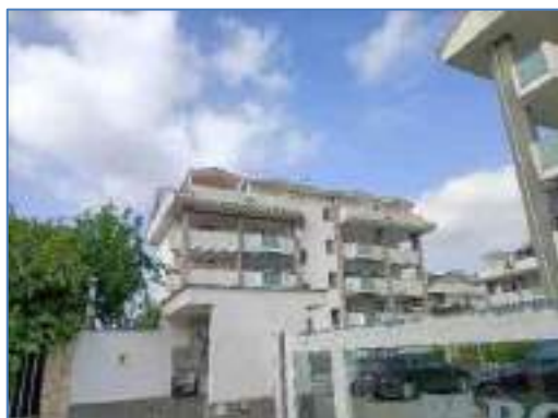
Fotografia 1 – Ingresso su via Leopardi
