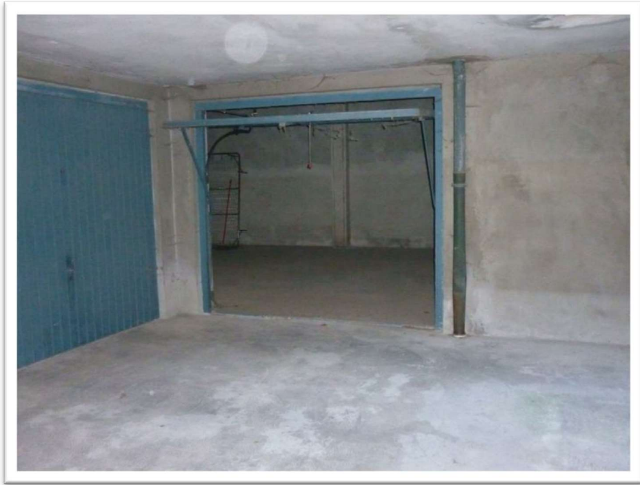
FOTOGRAMMA N. 3 - INGRESSO DEL BOX
