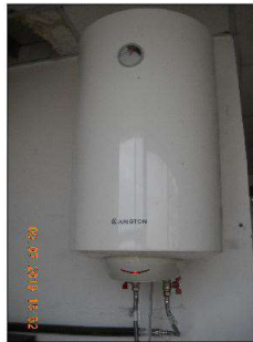
Foto 17 - Boiler elettrico
