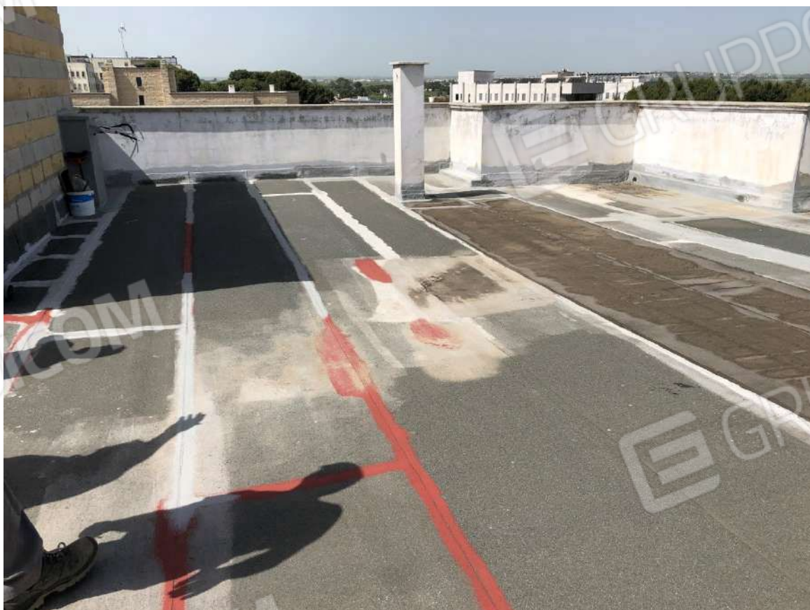
Foto n. 18 – I lastrici solari
