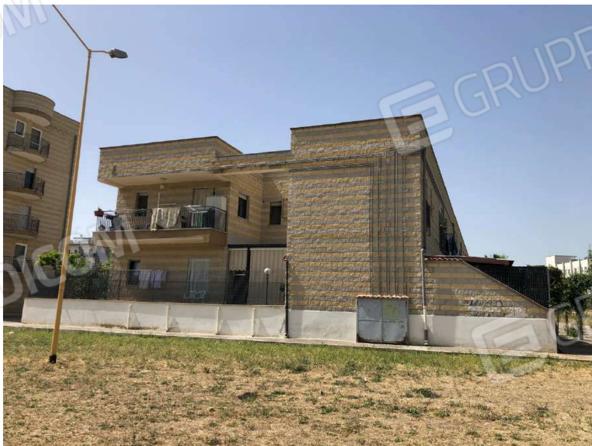
Foto n. 4 – Blocco A: prospetto laterale
