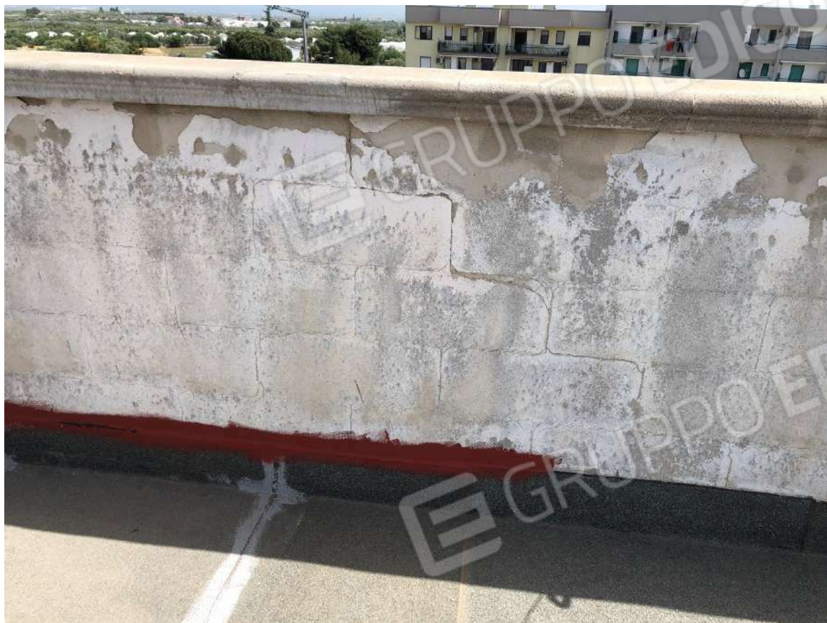
Foto n. 27 – I muretti d’attico
