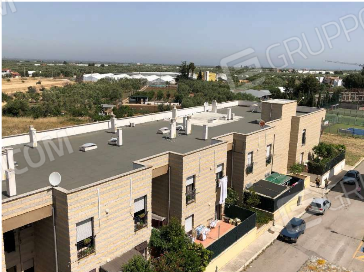
Foto n. 2 – Blocco A: prospetto principale su piazza Peppino Impastato
