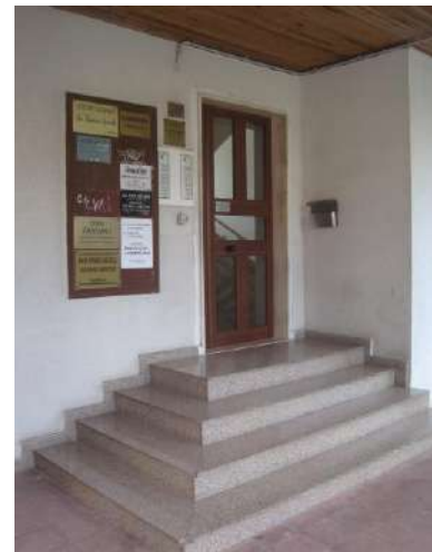
Portone di accesso al fabbricato dal civico 33 della Via Dalmazia.
