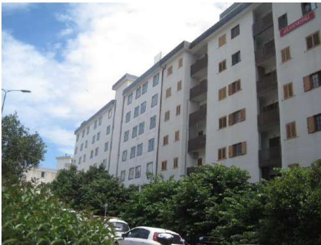
Ripresa fotografica esterna del fabbricato dalla pubblica Via Dalmazia.
