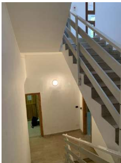
Vano scala condominiale di accesso al primo piano interrato del fabbricato.
