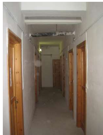
Connettivo di uso comune per l'accesso alle cantinole al primo piano interrato.
