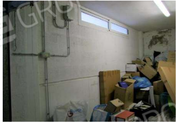
Foto 27 - Vista interna. Particolare finestra su parete Ovest
