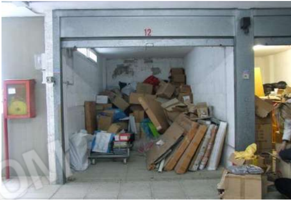
Foto 26 - Vista verso l'interno del garage
