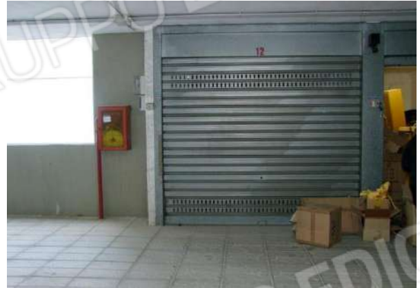
Foto 25 - Vista esterna della saracinesca d'ingresso al garage
