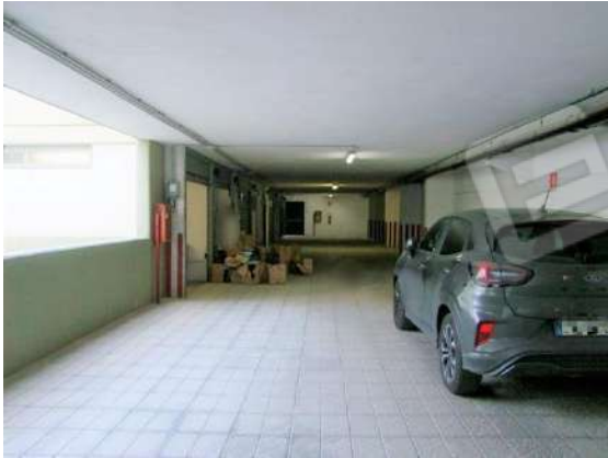
Foto 24 - Vista della corsia di manovra di accesso ai Beni N. 2 e N.3
