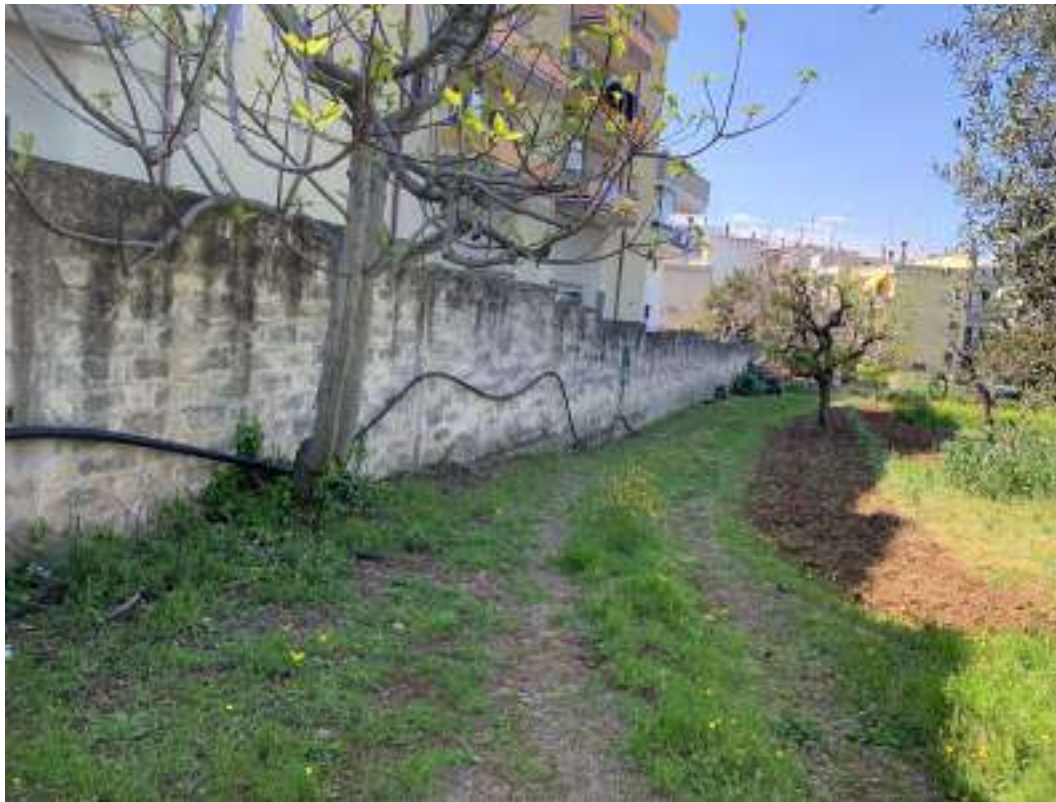
foto 2 . muratura confine Ovest
