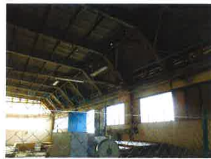
foto n. 22 (interno del capannone particolare dei controventi di copertura)
