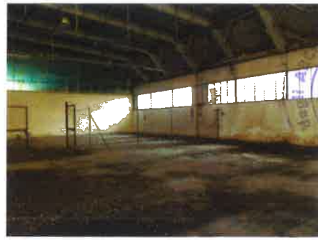
foto n. 18 (interno del capannone angolo Sud/Est)
