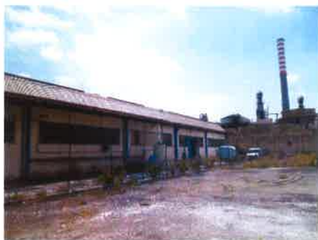
foto n. 7 (porzione oggetto di stima di cui alla particella 31 sub 13)
