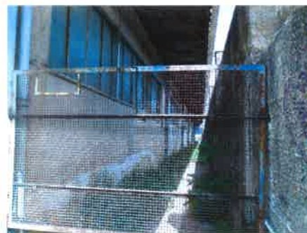
foto n. 8 (spazio di isolamento retrostante il capannone)
