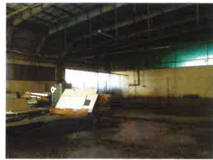
foto n. 20 (interno del capannone angolo Nord/Est con collocamento serbatoi)
