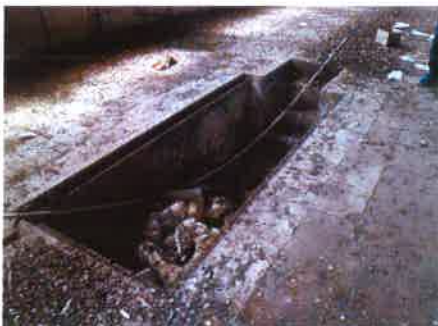
foto n. 23 (interno del capannone buca di ispezione a pavimento)
