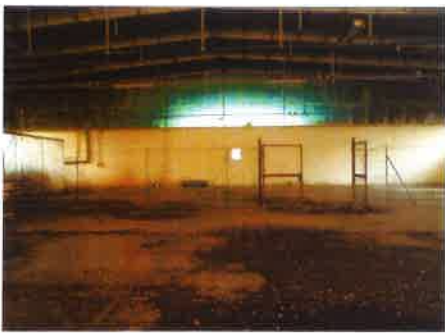
foto n. 19 (interno del capannone parete Est)
