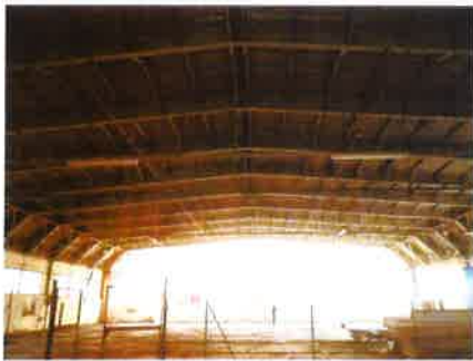
foto n. 21 (interno del capannone veduta d'insieme della copertura)
