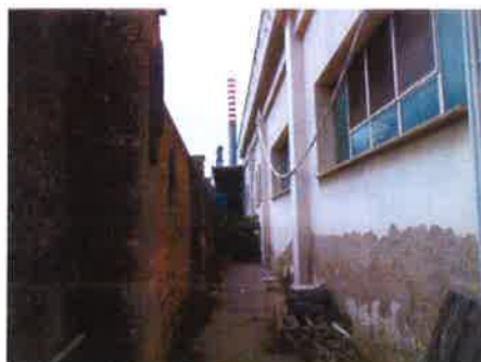
foto n. 9 (spazio di isolamento retrostante il capannone)
