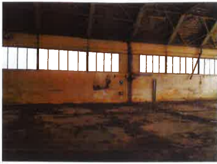
foto n. 17 (interno del capannone parete Sud)
