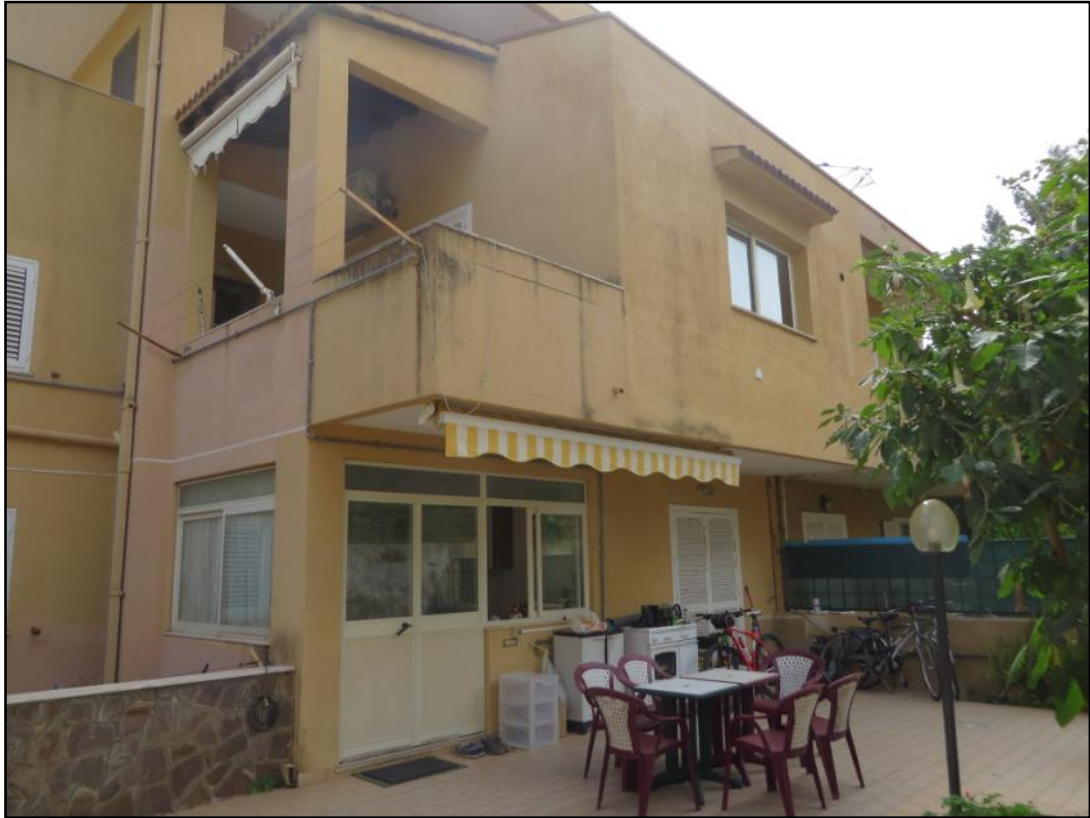
Accesso al piano seminterrato dalla cucina – veranda (retroprospetto)
