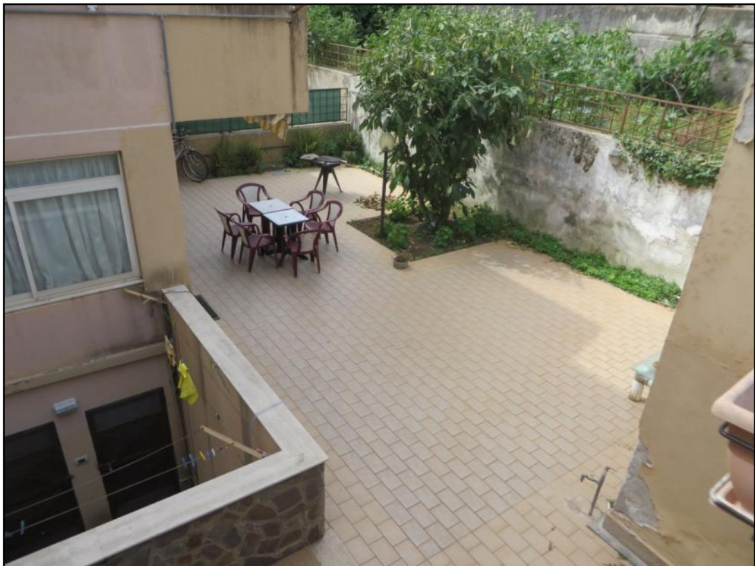
Terrazza di piano seminterrato adiacente il retrospetto
