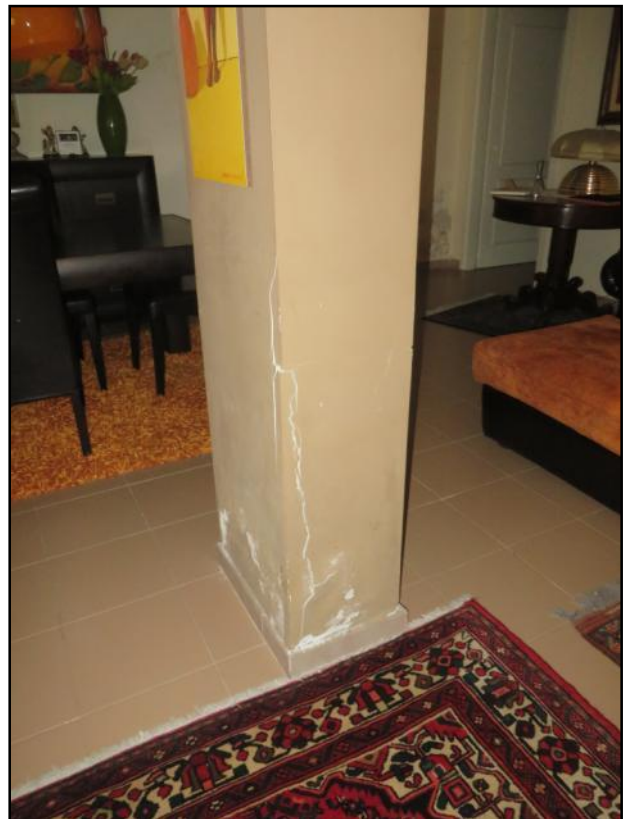
Ammaloramento (espulsione copriferro) dei pilastri
