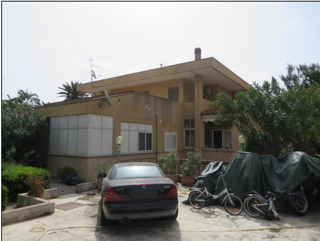
Prospetto laterale e retrospetto dell'unità immobiliare
