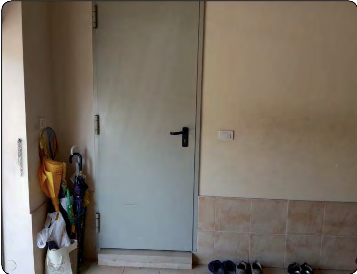
Foto 36: Piano terra - Porta di accesso alla abitazione dal box auto
