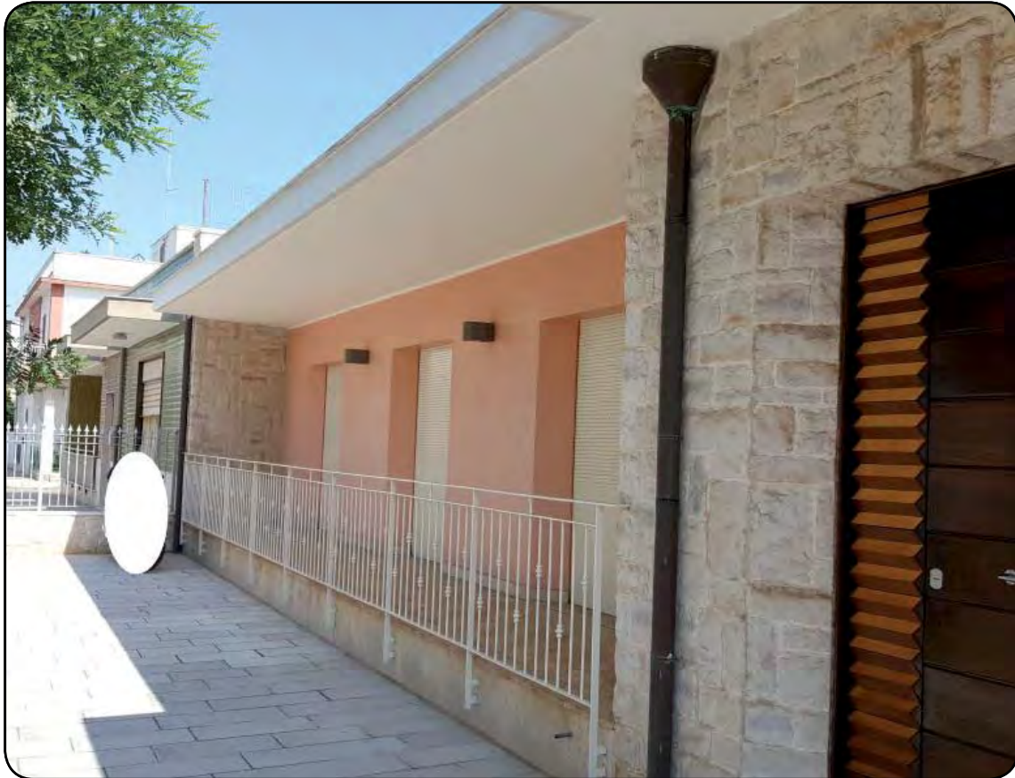
Foto 4: Balcone ed area pertinenziale antistanti
