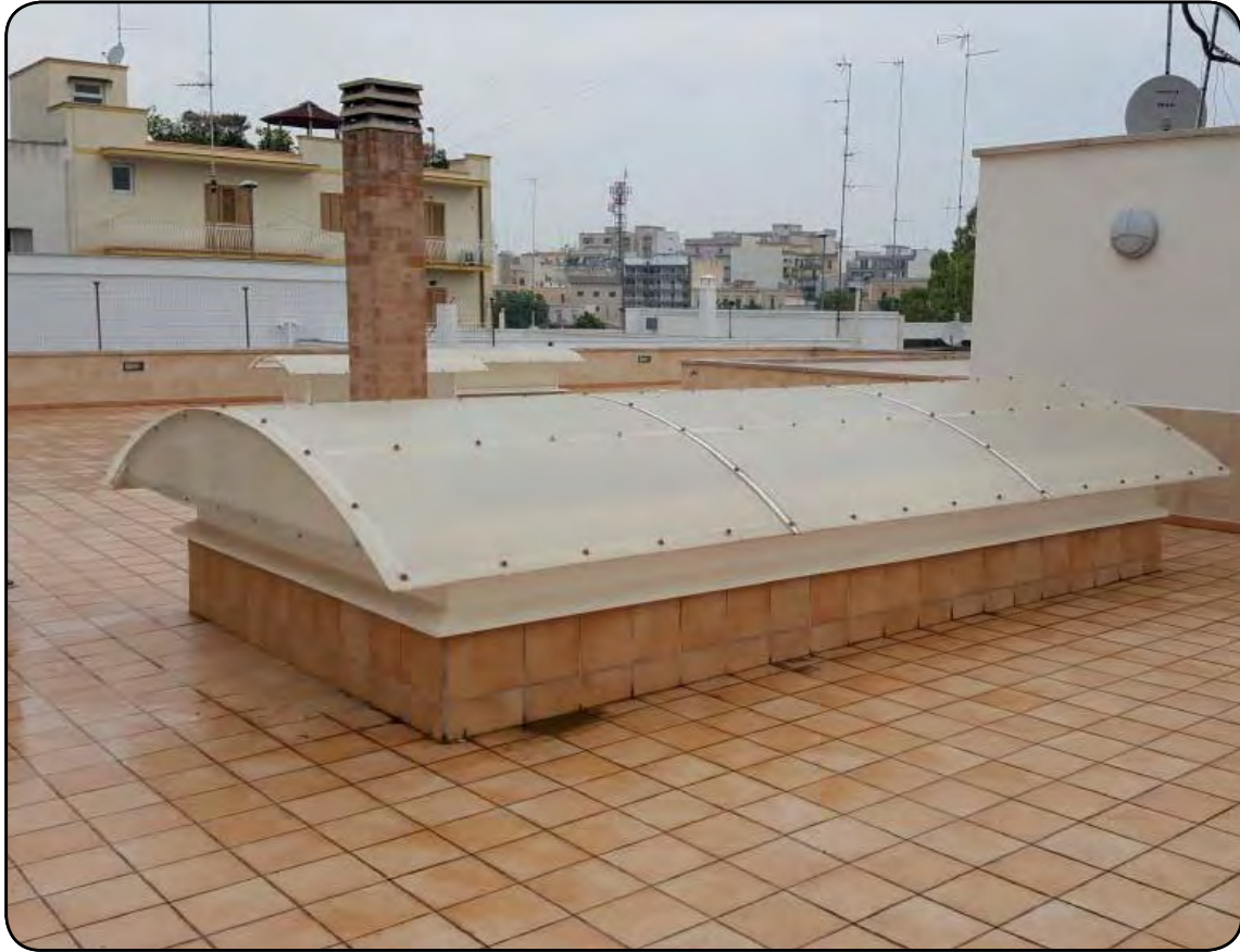
Foto 31: Lastrico solare - Lucernario presente sul vano scala
