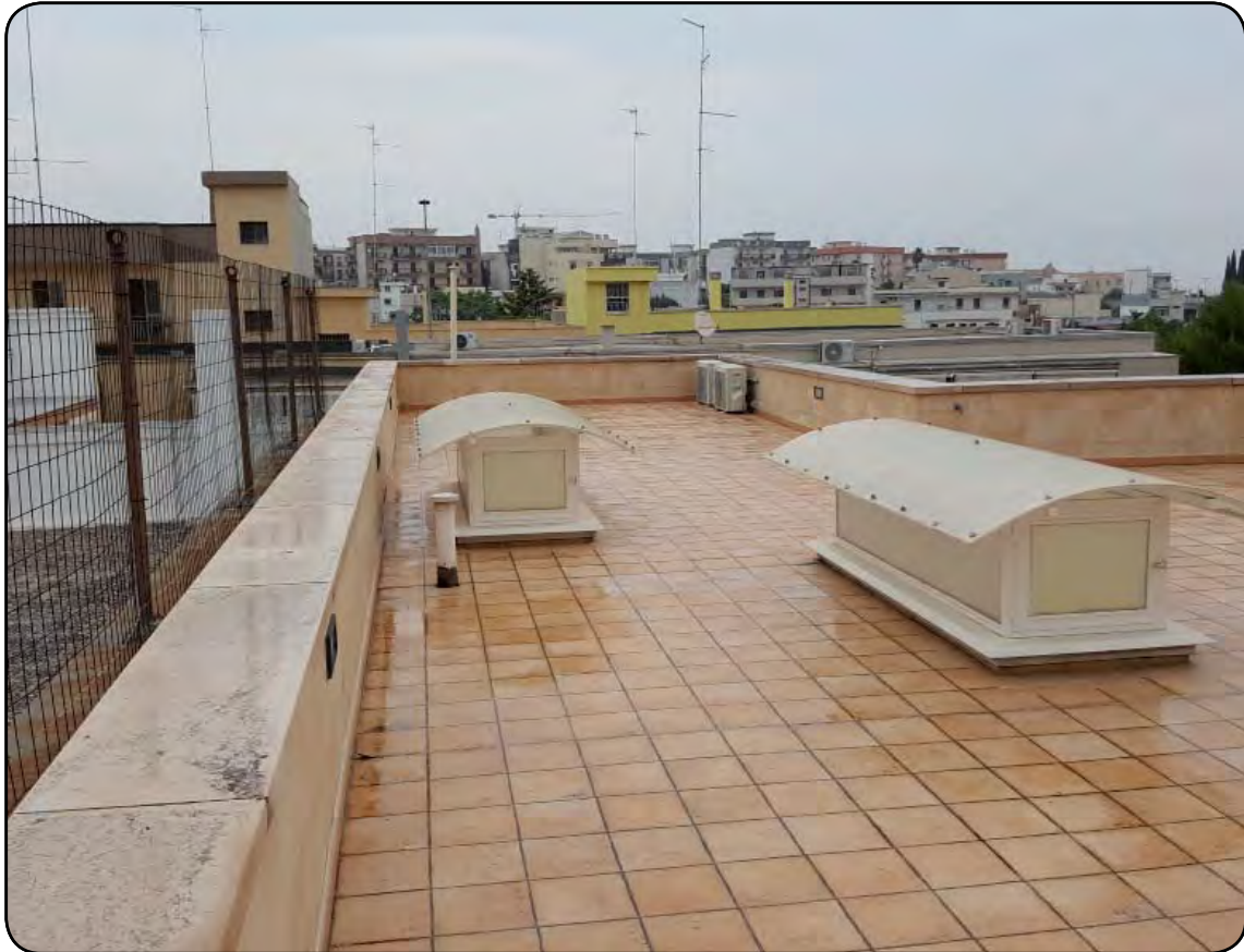
Foto 32: Lastrico solare - Lucernari presenti sul corridoio della zona notte
