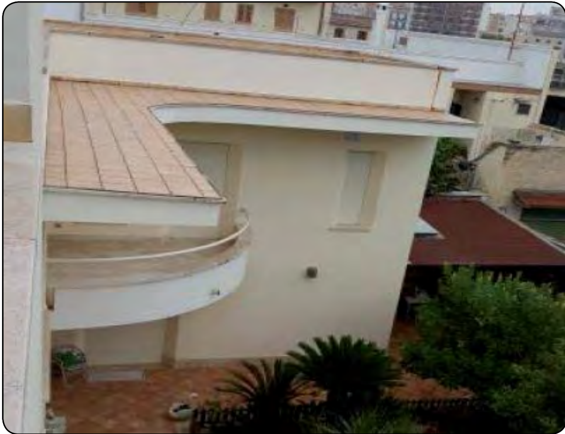
Foto 7: Prospetto interno Sud-Est
