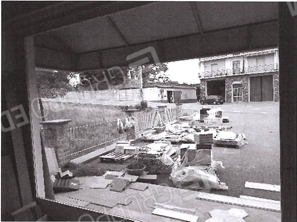
Vista interna locale esposizione / show room in piano terra
