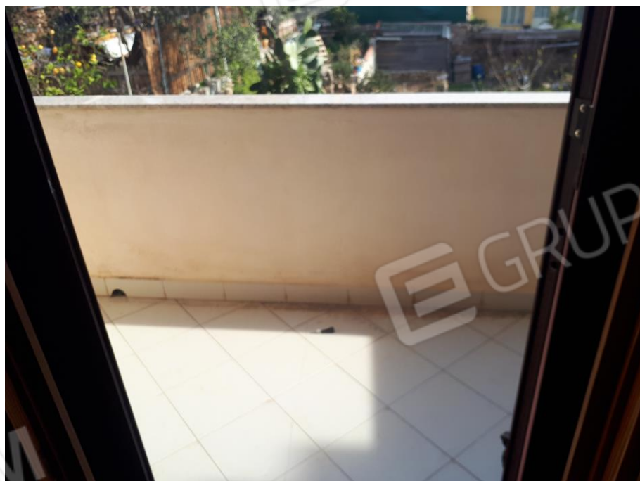
Foto 10 particolare del balcone;
