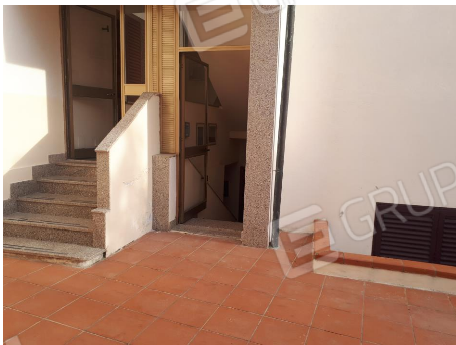
Foto 4 Accesso al piano seminterrato da B.C.N.C..
