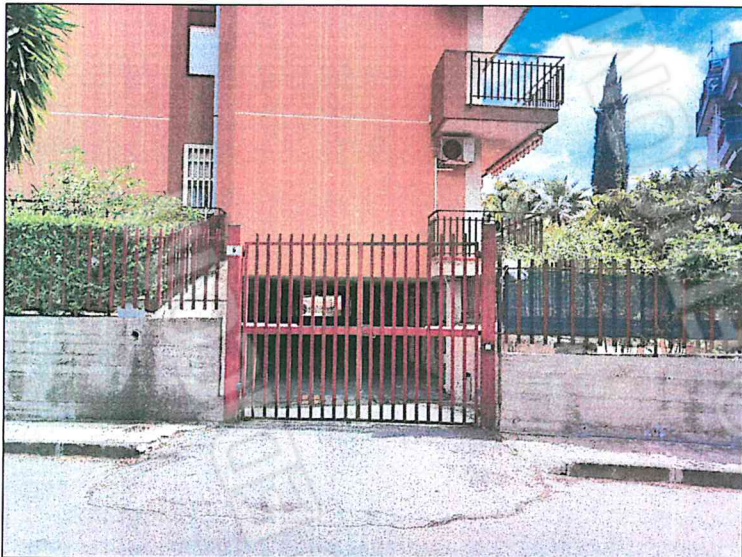
Foto 16 - Foto dell'ingresso carrabile da via Falcone n. 6 (con cancello automatico), ai garage siti a piano seminterrato.
