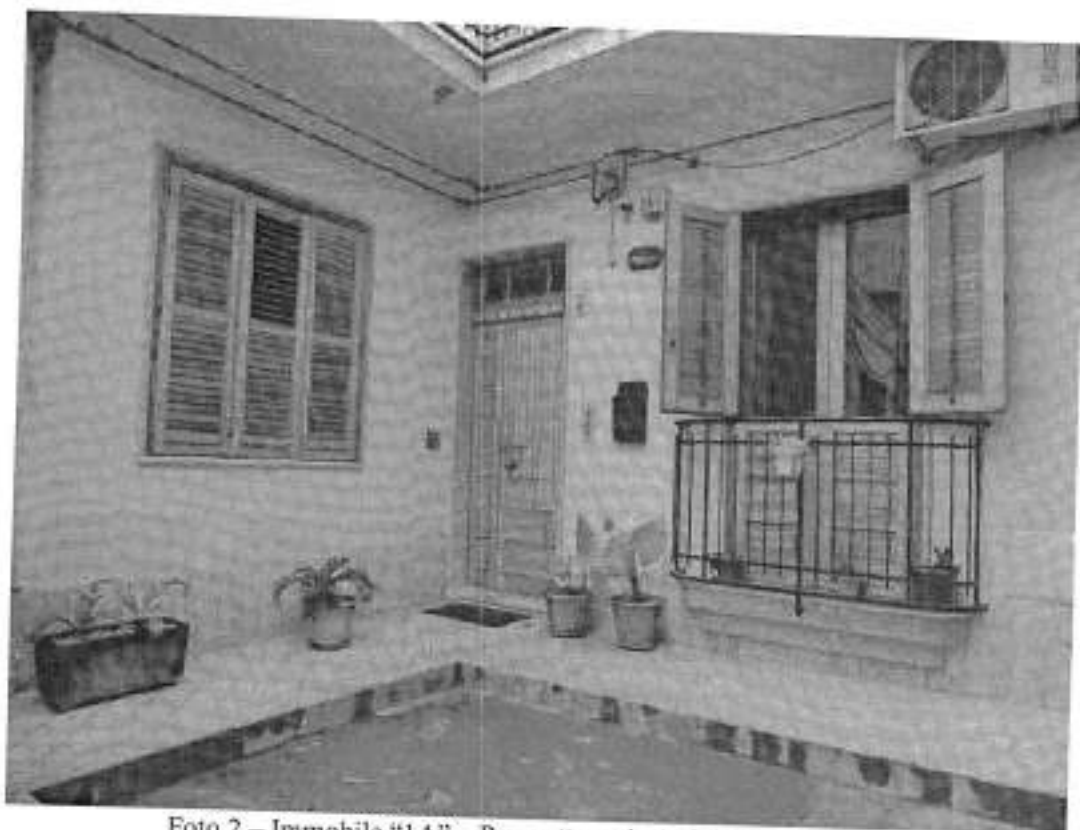
Foto 2 – Immobile “1A” – Prospetto sud-est del fabbricato
