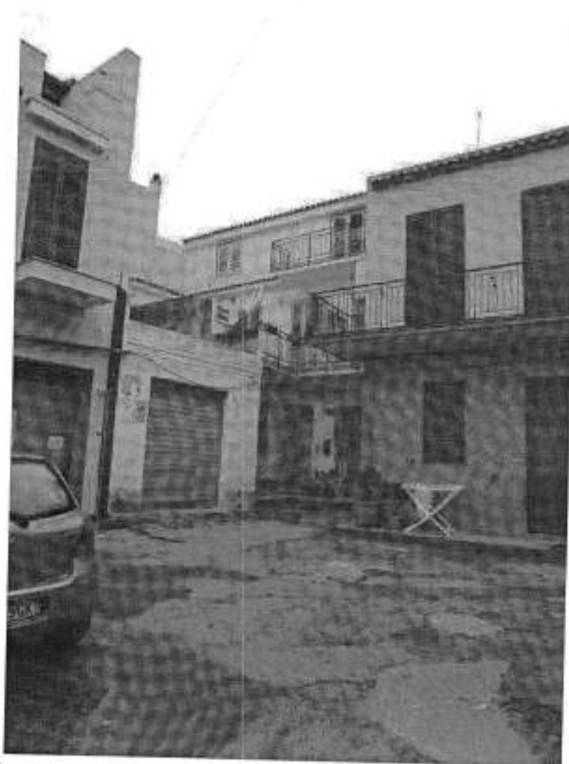
Foto 1 – Immobile "1A" – Cortile interno su cui si affaccia il fabbricato
