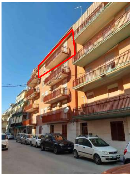
Foto 1 – Via O.M. Corbino, 56 – Augusta – Appartamento 4° piano
