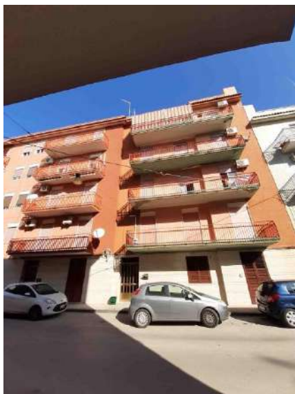
Foto 1 – Via O.M. Corbino, 60 – Augusta – Appartamento 3° piano
