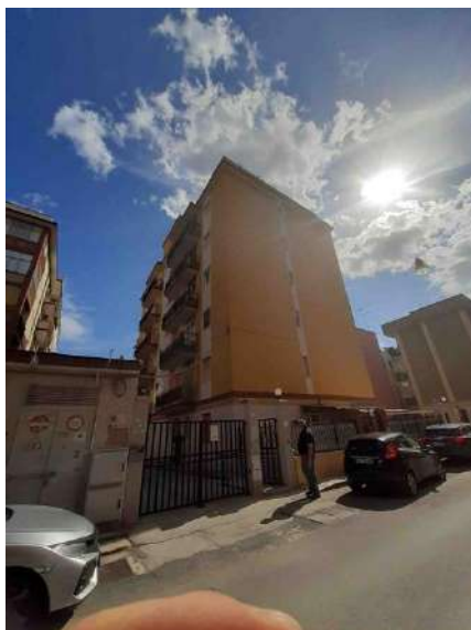
Foto 1 – Via XXV Aprile ingresso da Via A. Saluta, 36/B - Augusta
