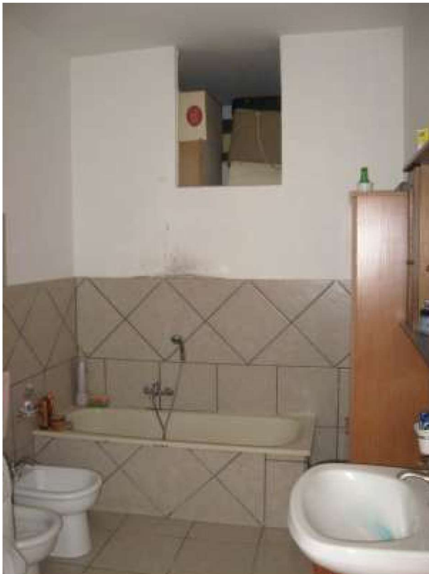
Figura 20 bagno dell'appartamento al piano terra
