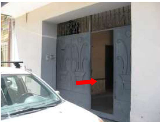
Figura 6 accesso dall'androne comune via A. Volta n.17
