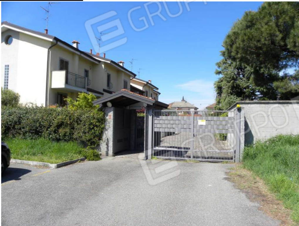
Cancello di accesso su strada via Cascine n. 40, Cornaredo (MI)
